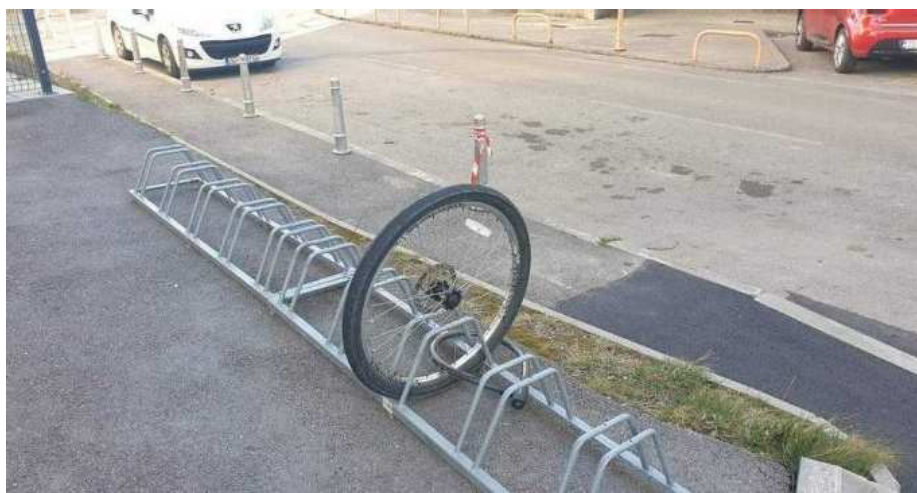
Slika 40. Neadekvatni stalci koji olakšavaju krađu i oštećuju bicikl (Sindikata biciklista, 4.2.2022)
