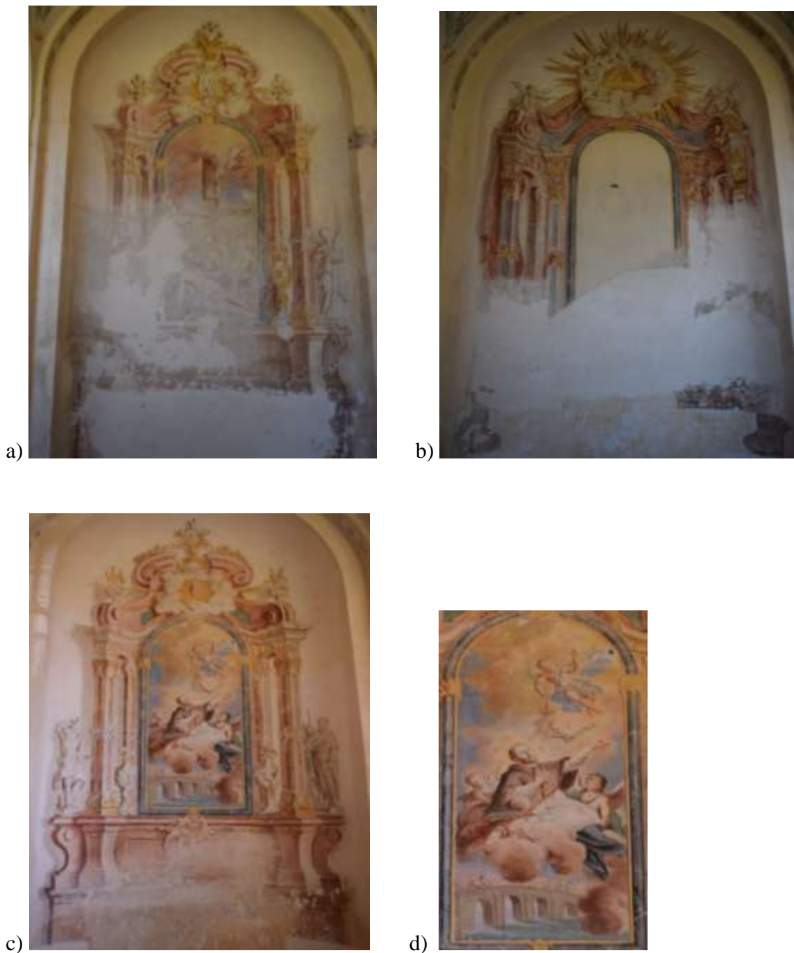
Slika 37. Glavna zgrada, dvorac Batthyány, zidni oslik u nišama na istočnom zidu broda dvorske kapele: a) oslikana oltarna slika u južnoj niši b) oslikana oltarna slika u srednjoj niši c) oslikana oltarna slika u sjevernoj niši d) detalj oslikane oltarne slike u sjevernoj niši
