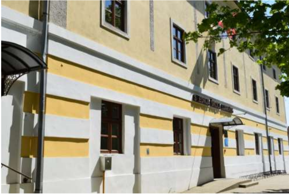
Slika 45. Istočna bočna zgrada sklopa dvorca Batthyány, pogled na zapadno pročelje zgrade
