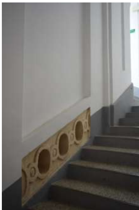
Slika 7. Glavna zgrada, dvorac Batthyány, detalj barokne balustrade na prvom stubišnom kraku, u jugozapadnom dijelu zgrade
