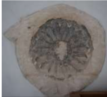
Slika 5. Glavna zgrada, dvorac Batthyány, ostatak gotičke ukrasne rozete iznad „češkog prozora“ na istočnom zidu zapadnog krila na drugom katu zgrade
