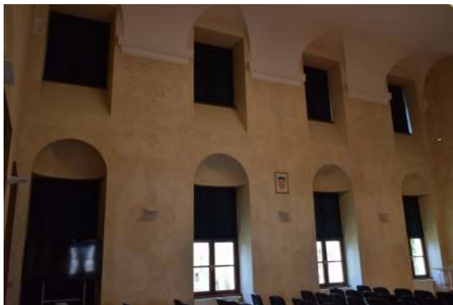
Slika 17. Glavna zgrada, dvorac Batthyány, pogled na zapadni zid „Velike dvorane“ na prvom katu zgrade
