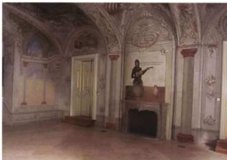
Slika 50. Zapadna bočna zgrada sklopa dvorca Batthyány, pogled na jugoistočni dio velike dvorane nakon radova
