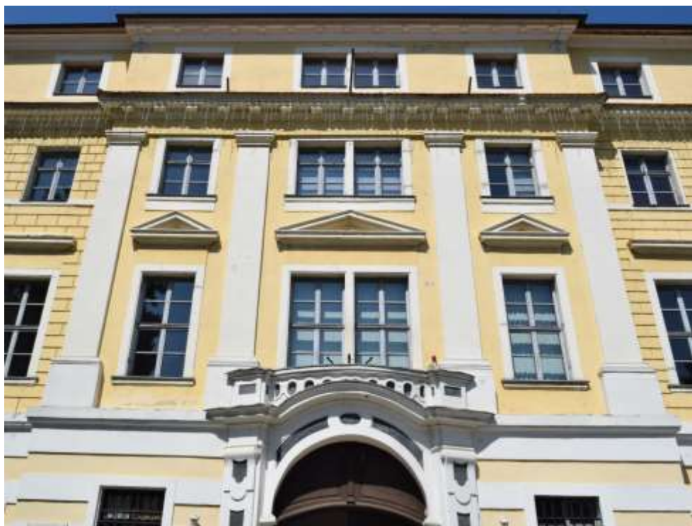
Slika 22. Glavna zgrada, dvorac Batthyány, detalj pročelja južnog krila zgrade
