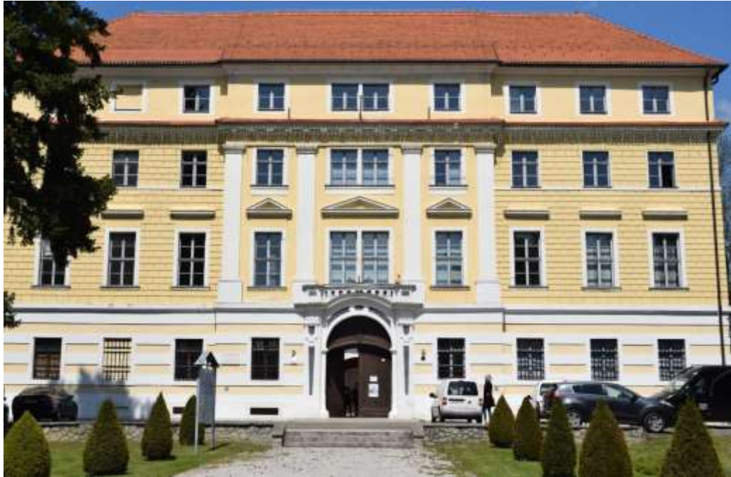
Slika 21. Glavna zgrada, dvorac Batthyány, pogled na pročelje južnog krila zgrade
