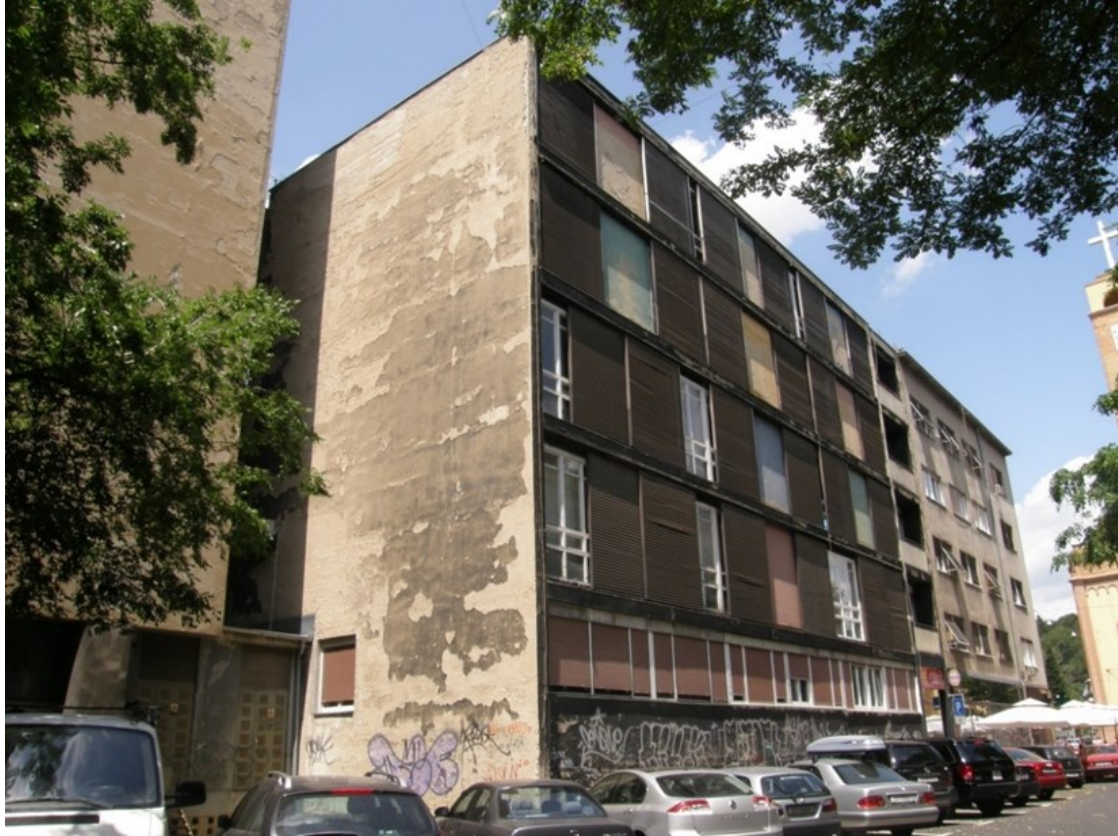
Slika 7. Pročelje četverokatnice u Vojnovičevoj ulici prije sanacije i obnove (2010.)
