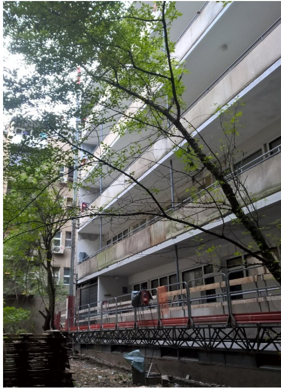
Slika 10. Radovi uklanjanja ograde od salonita s galerija četverokatnice
