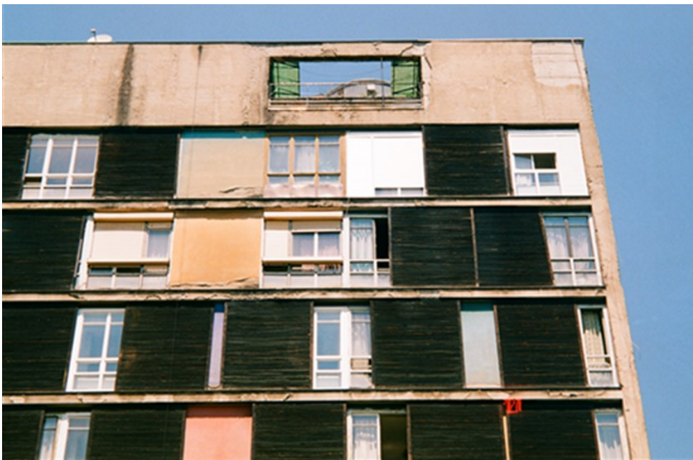
Slika 6. Detalj južnog pročelja nebodera prije obnove (2002. g.)
