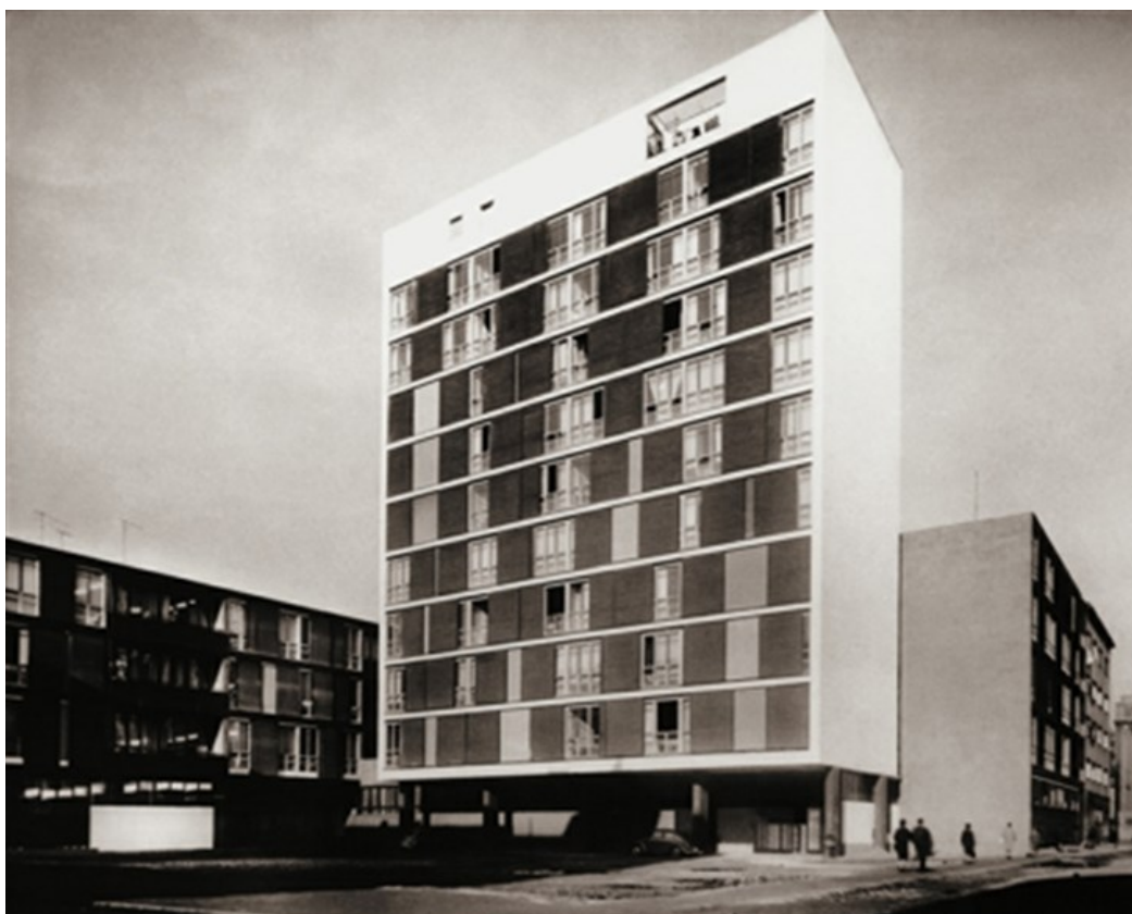
Slika 4. Sklop u Laganjinoj nakon izgradnje
