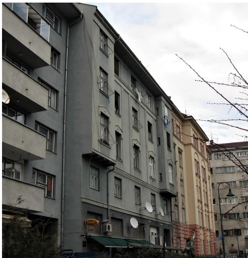
Slika br.145. Zgrada Salom (južna fasada), 2014.
