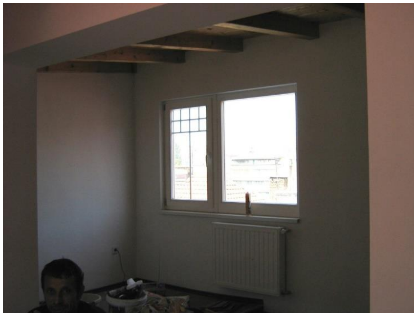
Slika br.167. Mansarda (Arnautovića dio), 2014.
