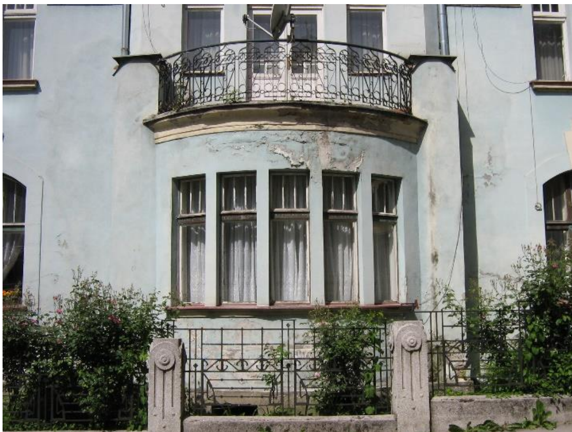
Slika br.40. Detalj balkonske lođe, 2013.
