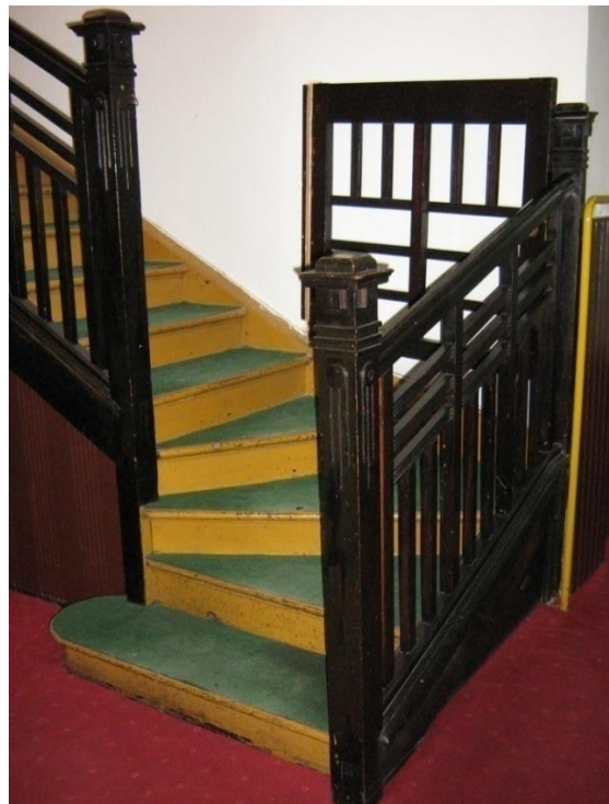
Slika br.31. Zgrada Miklau, detalj stubišta, 2014.
