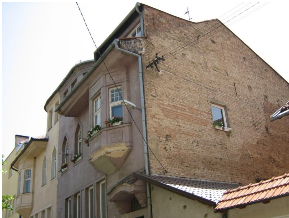
Slika br.162. Pogled sa zapadne strane (Čurčiča dio), 2014.
