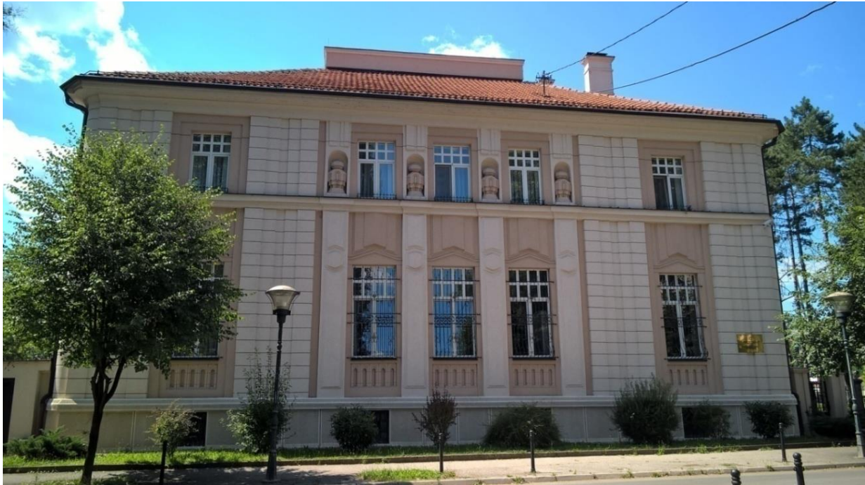
Slika br.189. Zgrada Mitropolije, Tuzla 2015.
