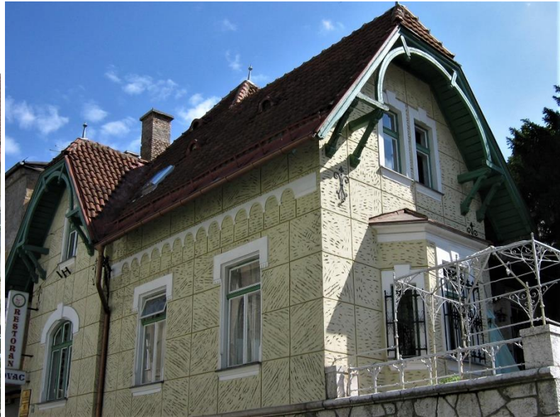
Slika br.25. Zgrada Miklau, bočni ulaz, 2014.
