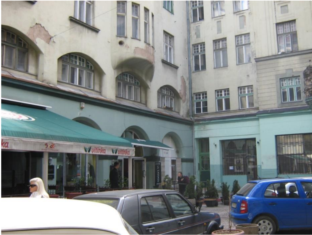
Slika br.146. Dvorišna fasada, sjeveroistočna strana (prizemlje i prvi kat), 2014.
