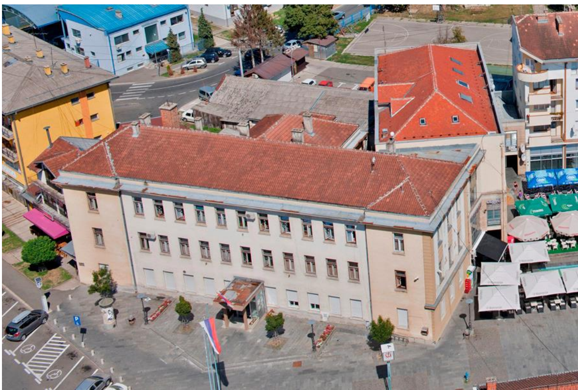
Slika br.80. Današnje stanje zgrade u Bosanskoj Dubici prema projektu iz 1908.
