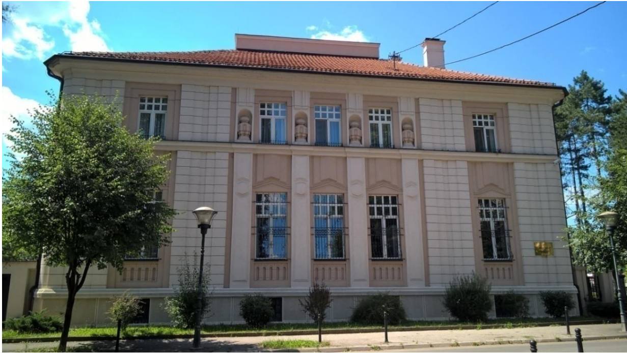
Slika br.189. Zgrada Mitropolije, Tuzla 2015.
