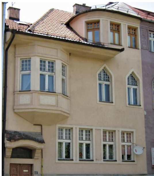
Slika br.174. Detalj ulične fasade zgrade Čurčić – Arnautović, 2014.
