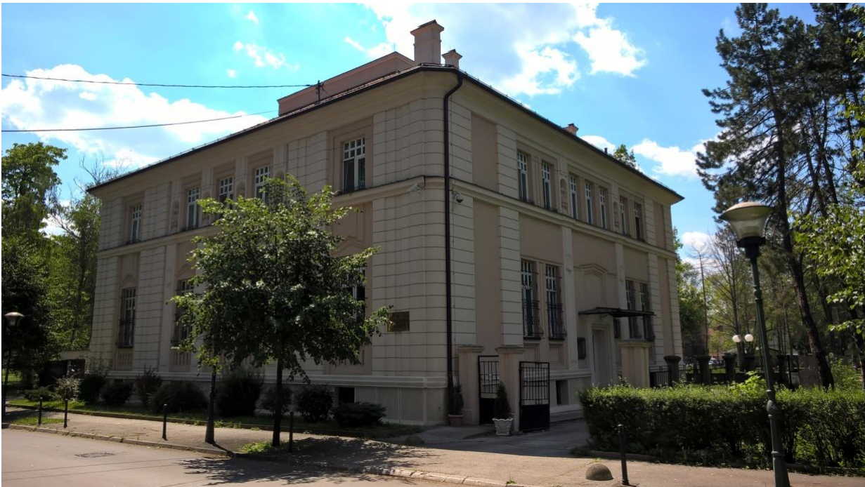
Slika br.190. Zgrada Mitropolije Tuzla, 2015.
