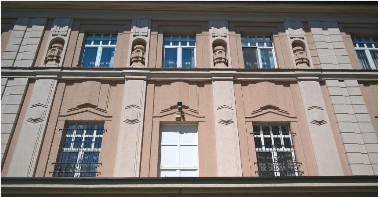
Slika br.191. Detalj, zgrada Mitropolije Tuzla, 2015.
