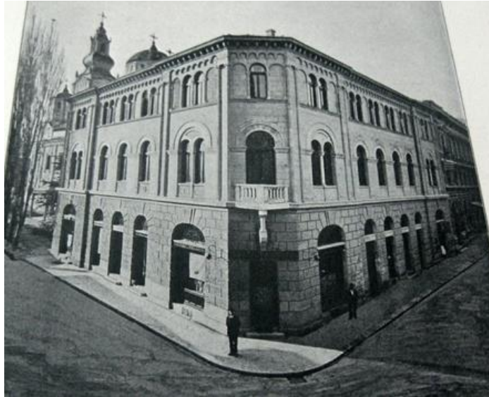
Slika br.64. Trgovačko-stambena zgrada Mitropolije u Sarajevu, 1900.
