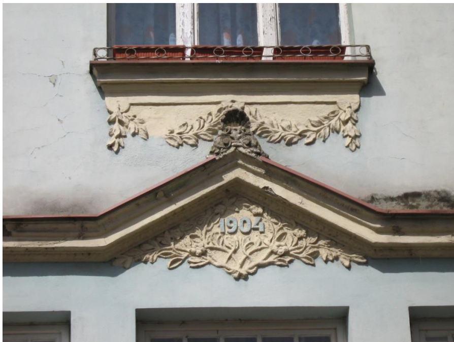
Slika br.42. Detalj na uličnoj fasadi s godinom izgradnje 1904., 2013.
