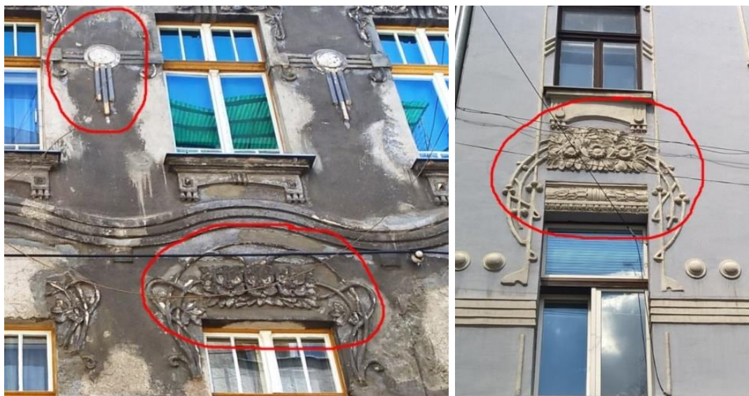
Slika br.178. Detalj nadprozornika zgrade Milana Jojkića
