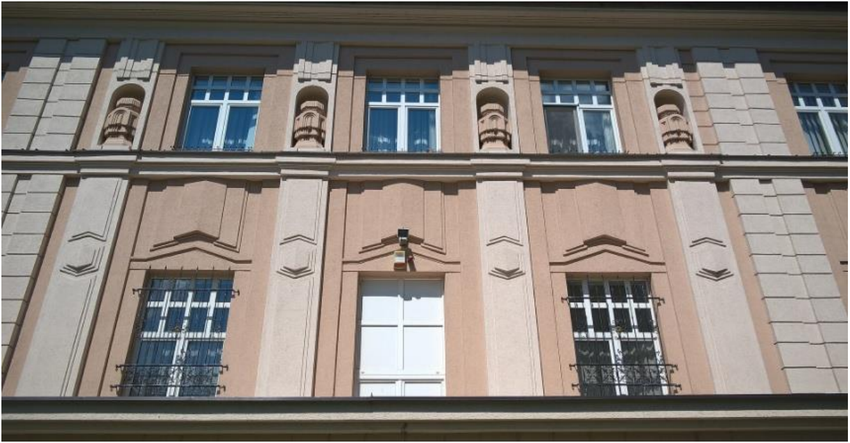
Slika br.191. Detalj, zgrada Mitropolije Tuzla, 2015.
