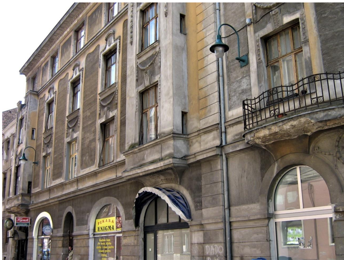
Slika br.95. Sjeverno pročelje, 2015.
