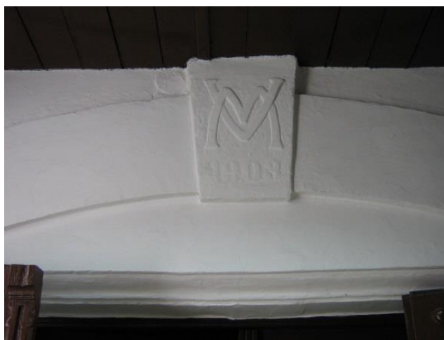
Slika br.32. Detalj iznad ulaznog portala s inicijalima vlasnika i godinom izgradnje 1903.
