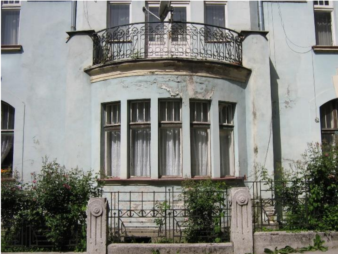
Slika br.40. Detalj balkonske lođe, 2013.
