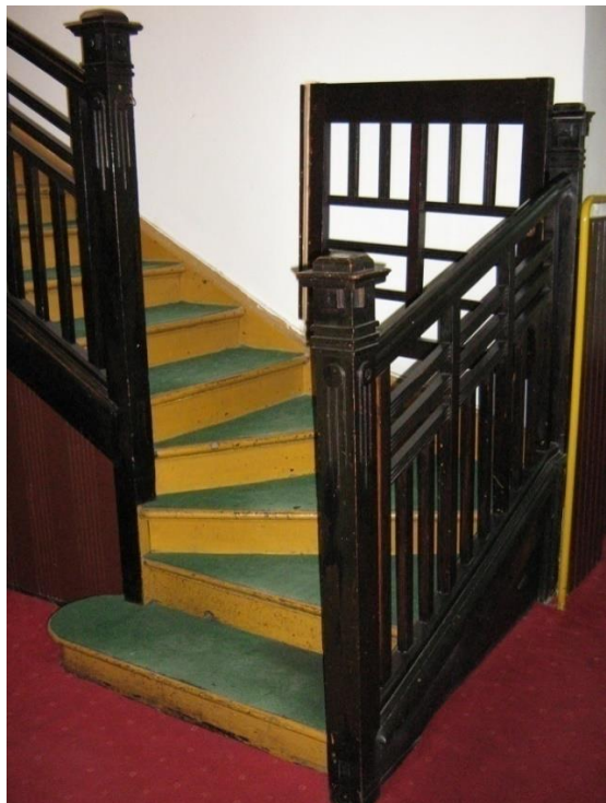
Slika br.31. Zgrada Miklau, detalj stubišta, 2014.
