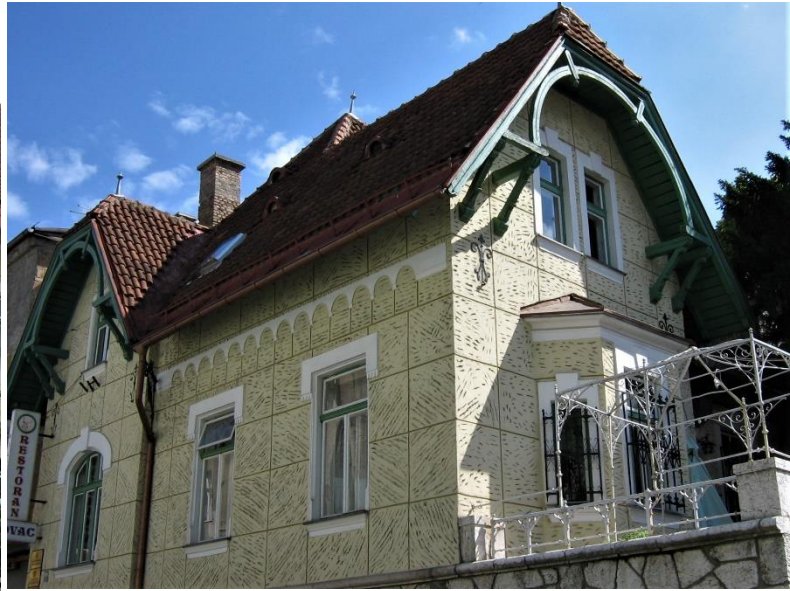
Slika br.25. Zgrada Miklau, bočni ulaz, 2014.
