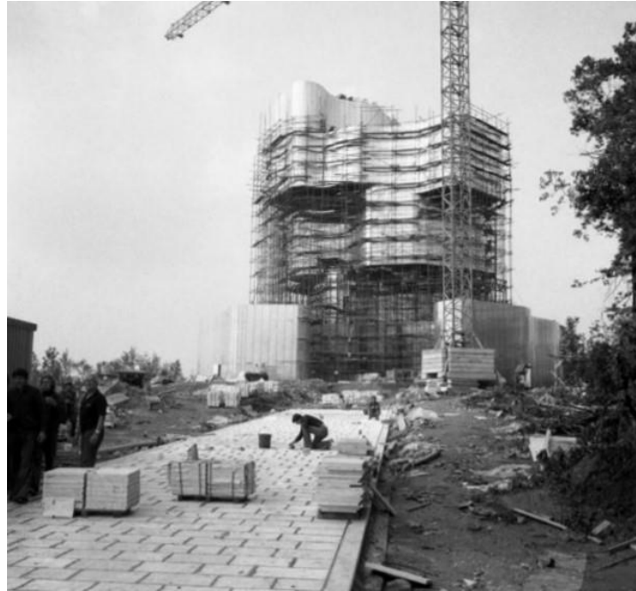
Slika 11. Izgradnja Spomenika na Petrovoj gori
