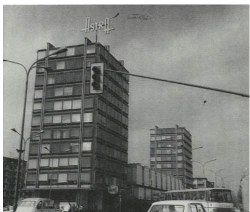
Slika 77. Poslovni tornjevi Astra i Commerc u Ljubljani, arhitekt Savin Severin, 1963. – 1970.
