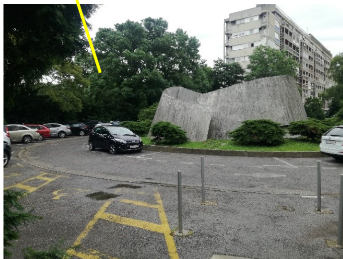
Slika 101, Slika 102 i Slika 103. Poslovni toranj Zagrepčanka . Pogled na sjevernu stranu građevine. Naznačen položaj rashladnog tornja i znaka o zabrani približavanja zbog opasnosti od padanja ploča.
