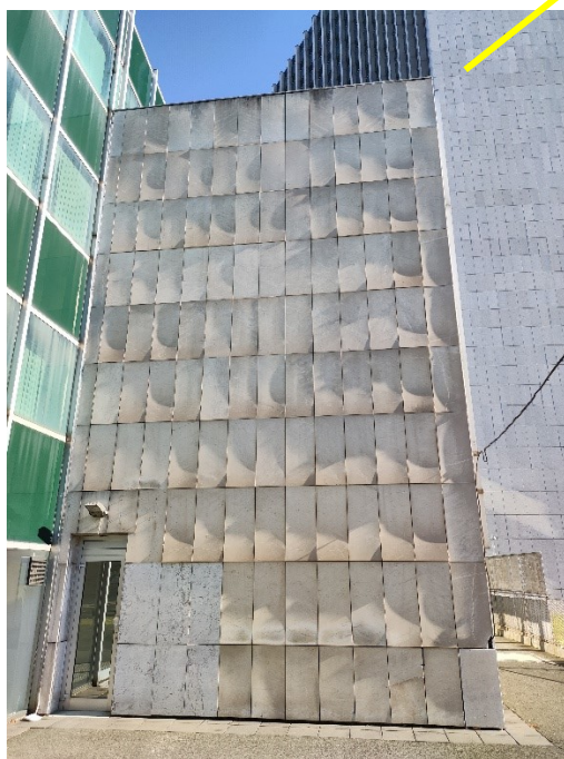
Slika 119, Slika 120 i Slika 121. Aneks Poslovnog tornja Zagrepčanka . Pogled s južne strane. Naznačena djelomična zamjena kamena na fasadi i izobličjenja kamena.
