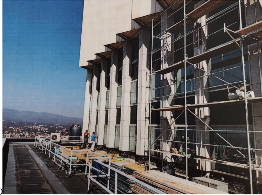
Slika 96. Obnavljanje stupova na terasi zapadnog pročelja Zagrepčanke, 2016. – 2018.
