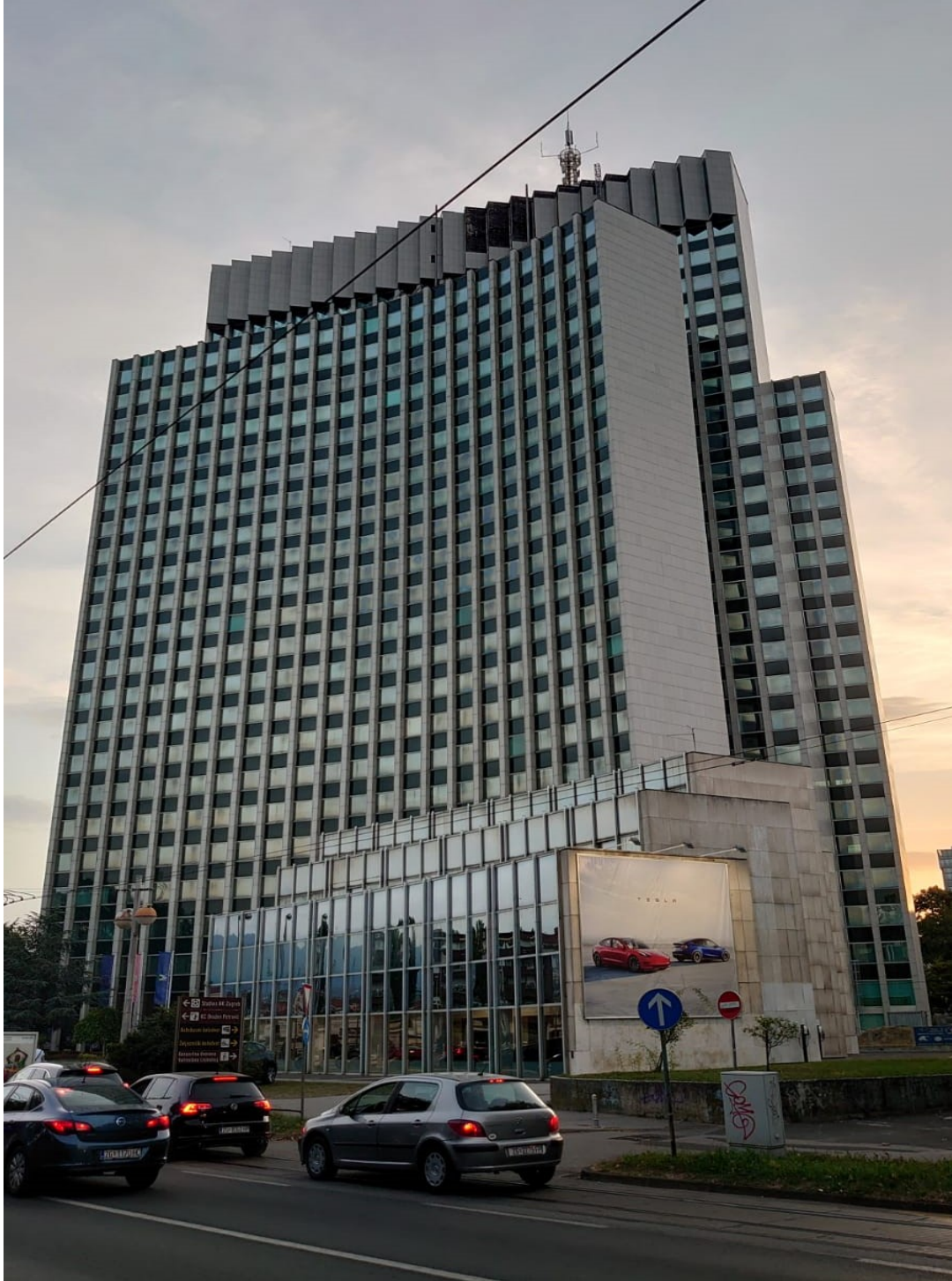
Slika 100. Poslovni toranj Zagrepčanka. Pogled na jugozapadnu stranu građevine.
