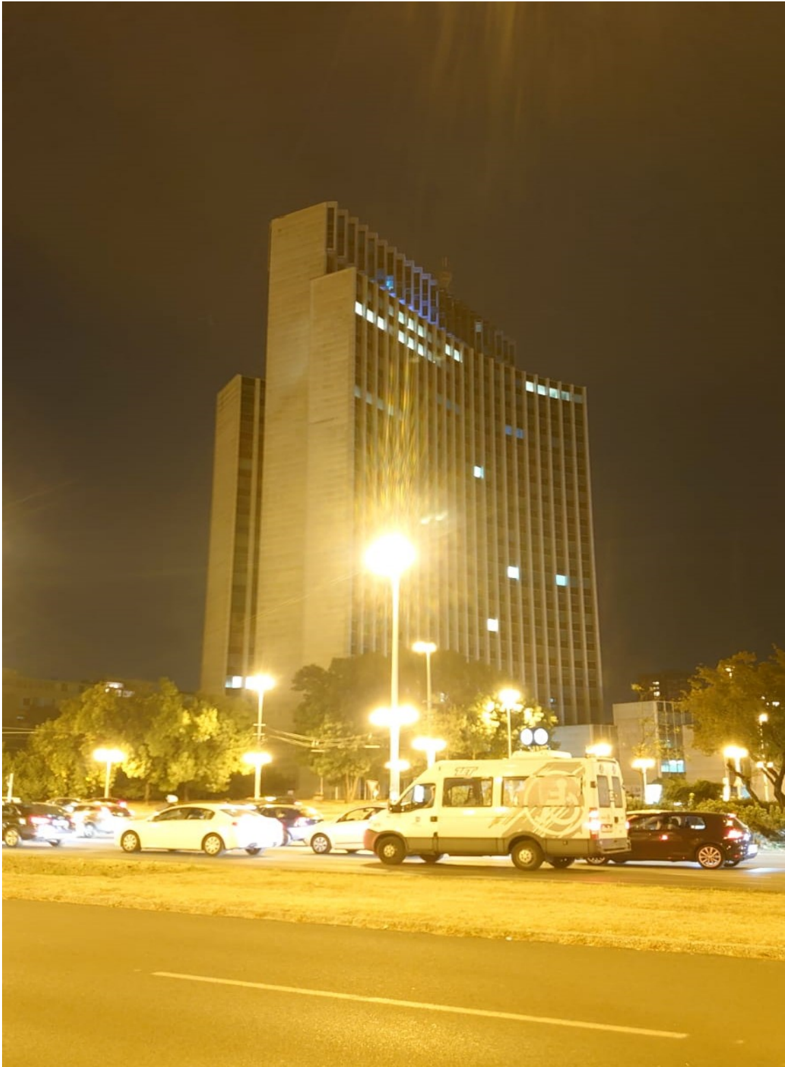
Slika 101. Poslovni toranj Zagrepčanka u večernjim satima. Pogled na Sjeverozapadni dio građevine.
