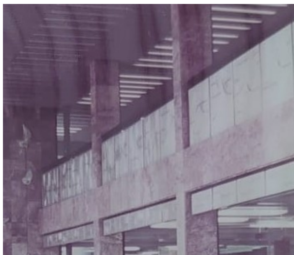
Slika 57. Interijer poslovnice Ljubljanske banke , aneks poslovnog tornja, detalj s prikazom postavljenih ploča s reljefima na ogradi polukata
