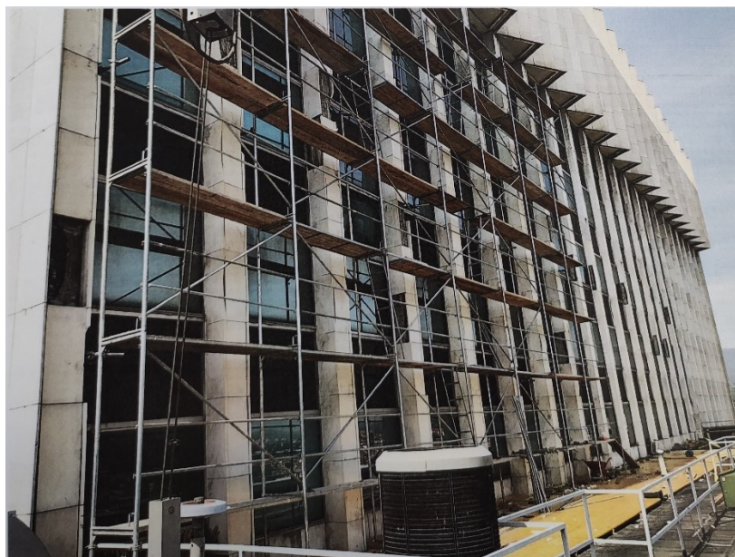
Slika 95. Obnavljanje stupova na terasi istočnog pročelja Zagrepčanke, 2016. – 2018.
