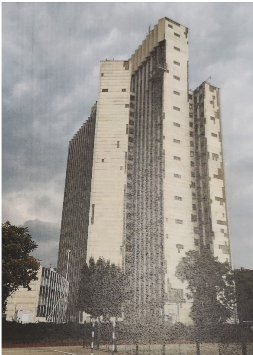
Slika 97. Južno pročelje Zagrepčanke prije obnove
