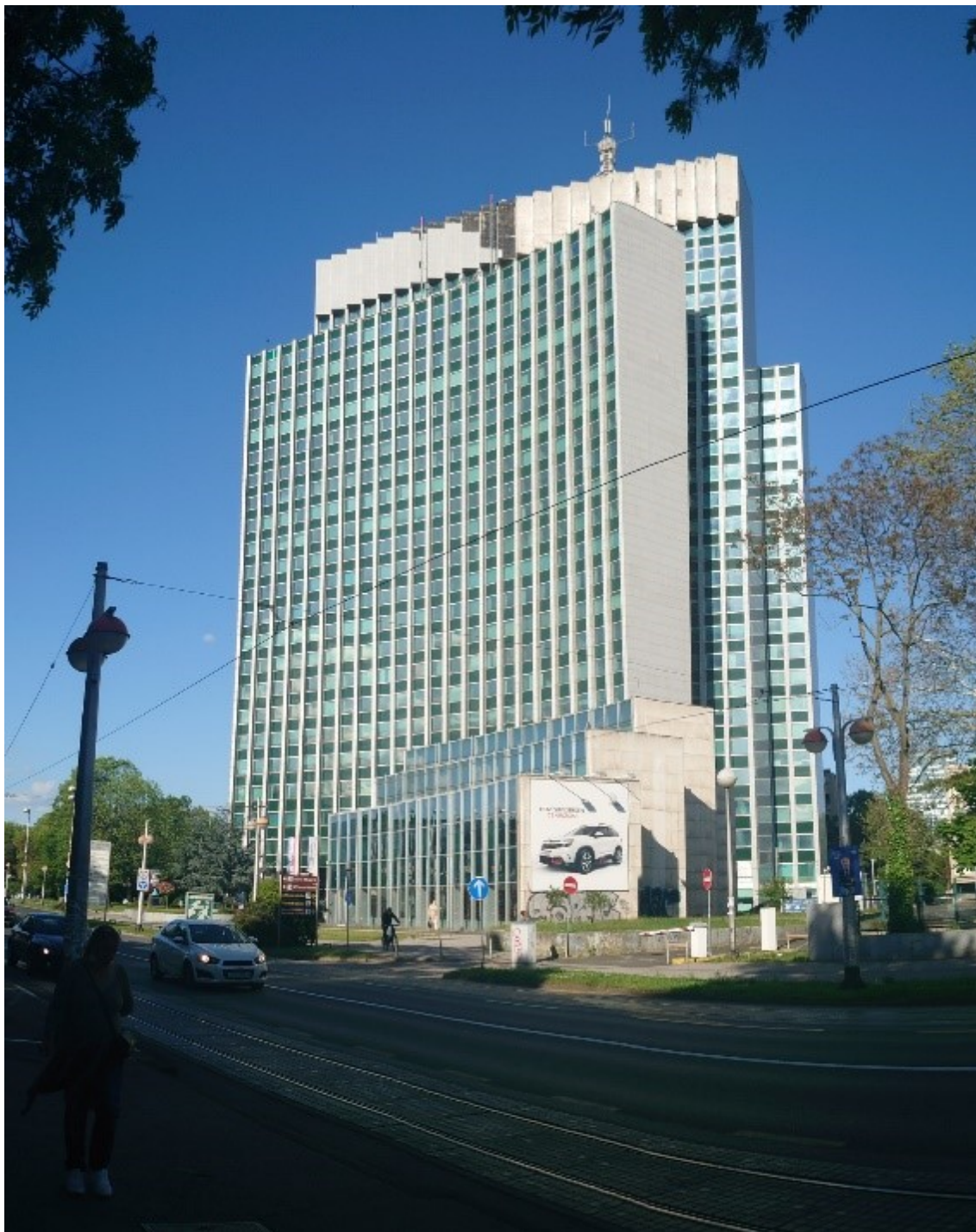
Slika 99. Poslovni toranj Zagrepčanka. Pogled na jugozapadnu stranu građevine.
