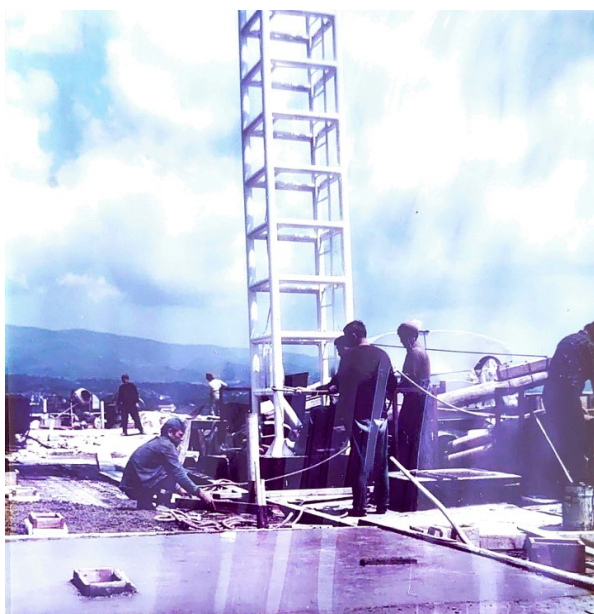
Slika 41. Montaža telekomunikacijskog tornja na vrhu Zagrepčanke
