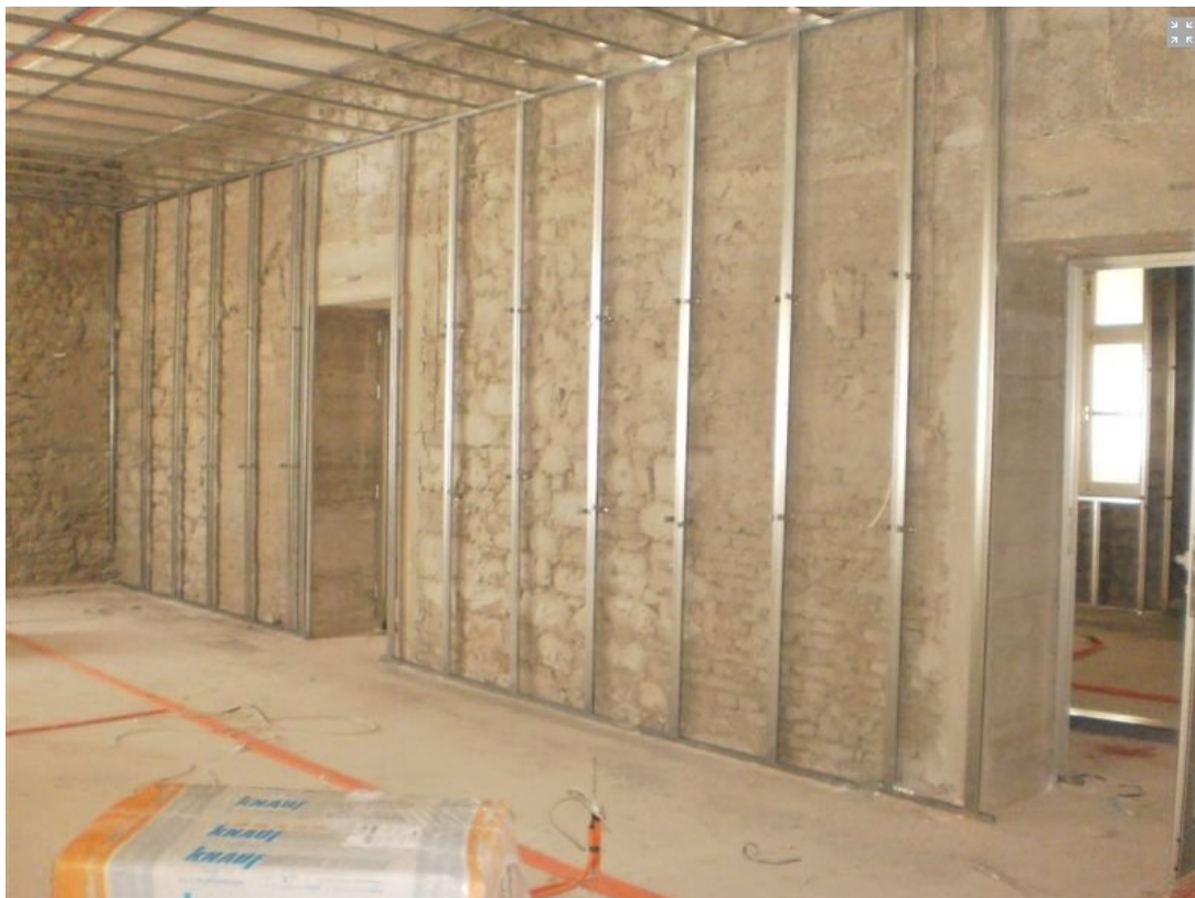
sl. 115. Aluminijska podkonstrukcija montirana na unutrašnje zidove prvog kata zgrade Prirodoslovnog muzeja i Gradske knjižnice, na koje će se postaviti gips-kartonske ploče. Fotografirano tijekom obnove zgrade koja je trajala od 2008. do 2015. godine
