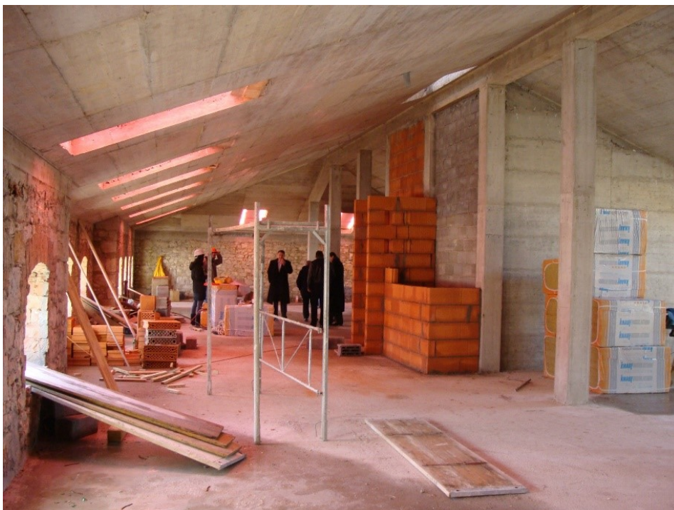
sl. 104. Novo potkrovlje bivše zgrade uprave i stanovanja duhanske stanice u Metkoviću, danas Prirodoslovnog muzeja i Gradske knjižnice, fotografirano tijekom trajanja obnove zgrade u razdoblju od 2008. do 2015. godine. Vidljiva je nova, armiranobetonska krovna konstrukcija s krovnim prozorima, koja je izvedena umjesto ranije drvene, čime se povećala površina i svjetlina tavana
