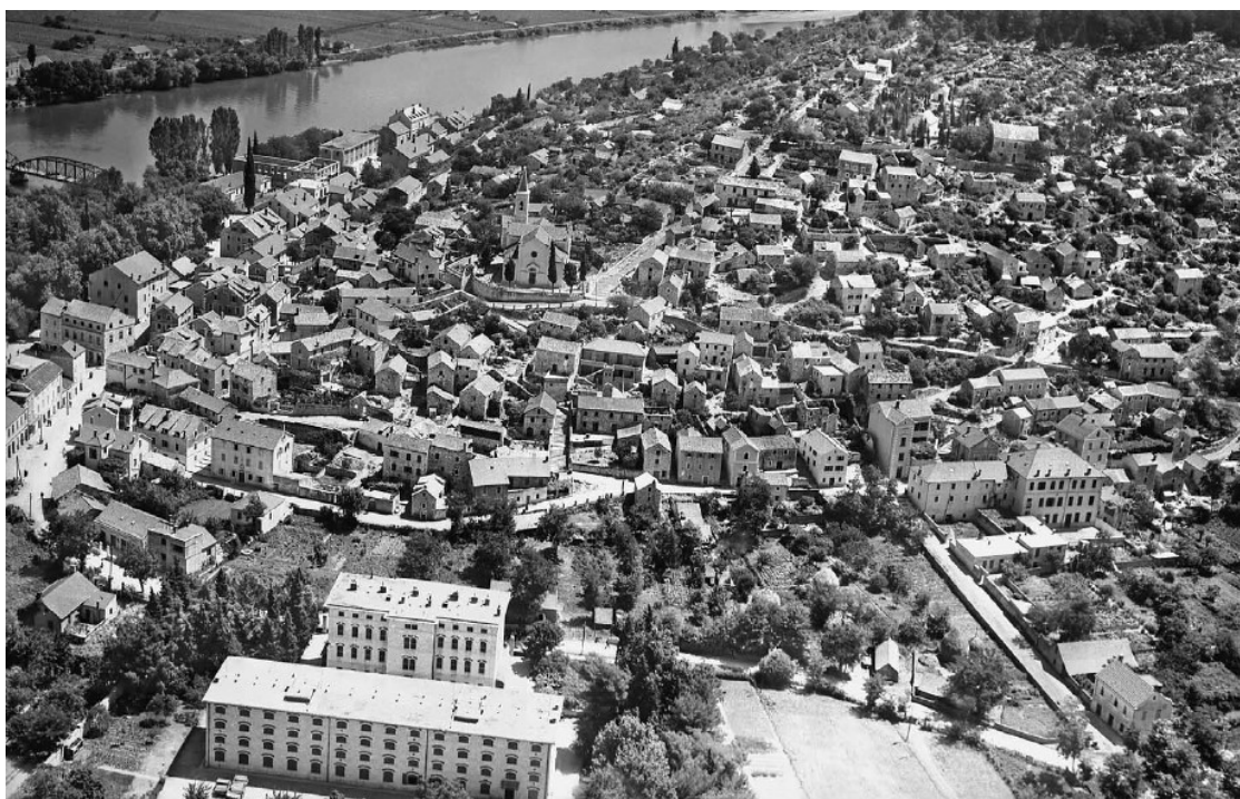
sl. 64. Zgrada prvog (kamenog) skladišta i zgrada uprave i stanovanja (danas Prirodoslovnog muzeja i Gradske knjižnice) duhanske stanice u Metkoviću u širem krajoliku (u prvom planu na fotografiji). U zadnjem je planu i rijeka Neretva, uzrok visokoj zemnoj vodi u okolnom prostoru. Snimljeno 1939. godine iz zraka u smjeru istoka
