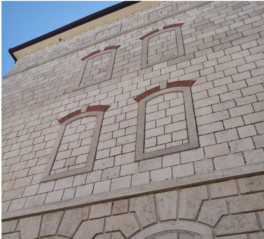
sl. 90. Slijepi (zazidani) prozori na sjevernom pročelju bivše zgrade uprave i stanovanja duhanske stanice u Metkoviću, danas Prirodoslovnog muzeja i Gradske knjižnice
