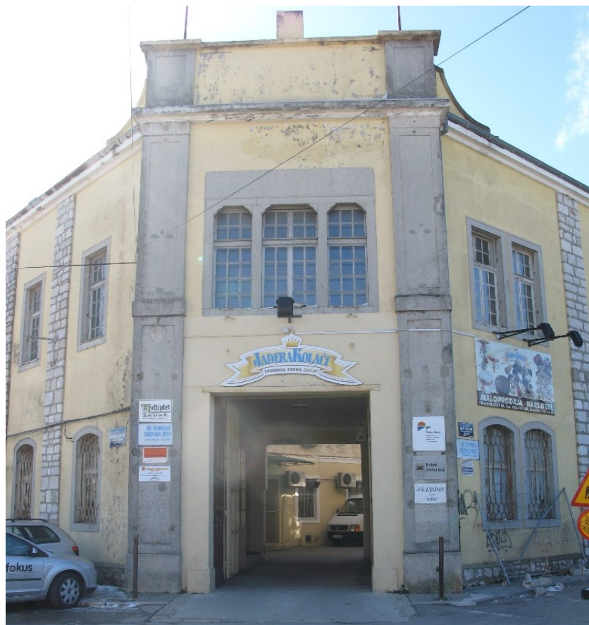
sl. 18. Glavno pročelje zgrade sklopa bivše Preparandije i Tvornice duhana u Zadru
