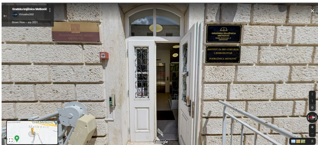
sl. 94. Glavni ulaz zgrade Prirodoslovnog muzeja i Gradske knjižnice, smješteno na njezinom zapadnom pročelju. Na slici je vidljiva i oznaka Prirodoslovnog muzeja, kao i drugih institucija koje se nalaze u zgradi. Snimljeno u srpnju 2021.
