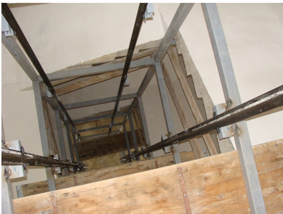
sl. 110. Proces ugradnje lifta unutar centralnog stubišta zgrade bivše uprave i stanovanja duhanske stanice u Metkoviću, danas Prirodoslovnog muzeja i Gradske knjižnice. Fotografirano tijekom obnove zgrade koja je trajala od 2008. do 2015.
