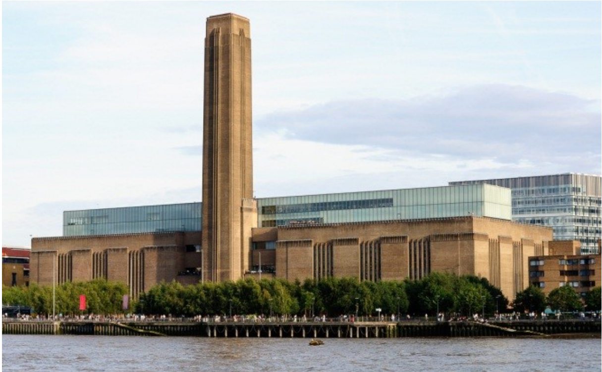
sl. 25. Zgrada nekadašnje termoelektrane Bankside u Londonu, danas prenamijenjena u Tate Modern Gallery
