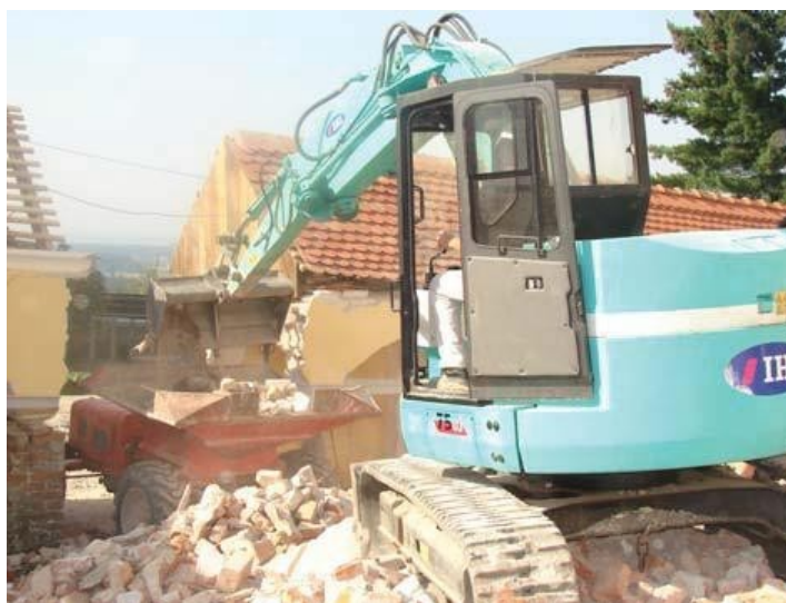
Slika 63. Uklanjanje urušenog materijala
