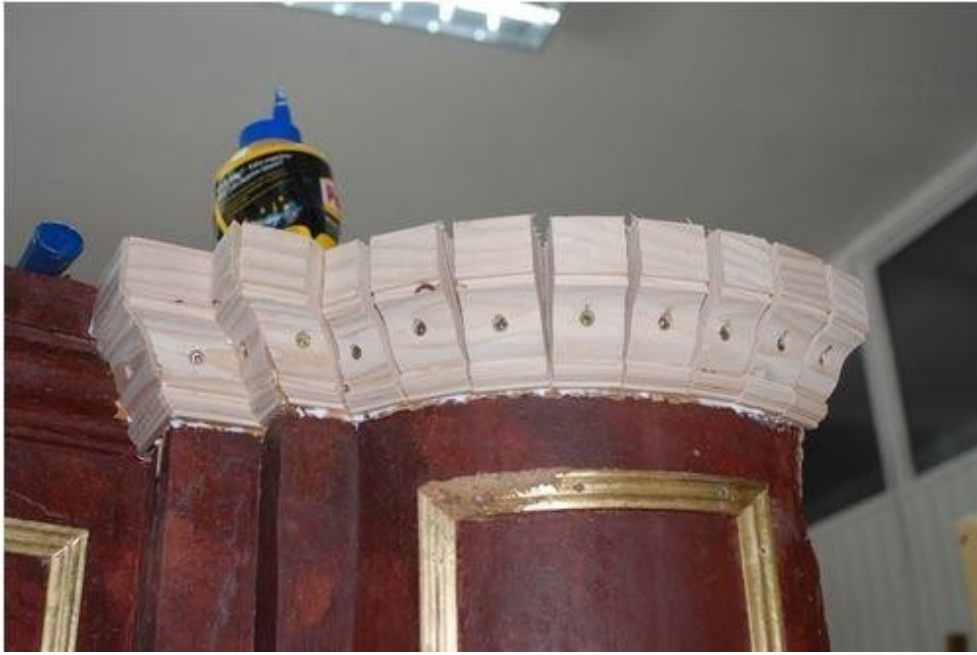
Slika 92. Detalj rekonstrukcije stupa u zamjenskom drvu u restauratorskoj radionici
