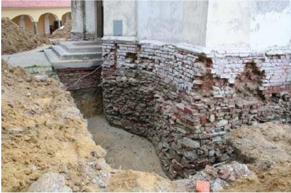
Slika 59. Hidroizolacijski radovi prije urušavanja
