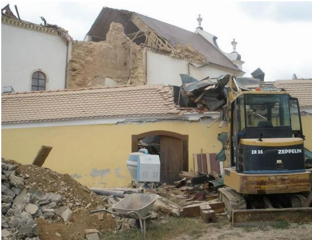
Slika 70. Oštećenje na cinktoru (snimljeno 2008.)
