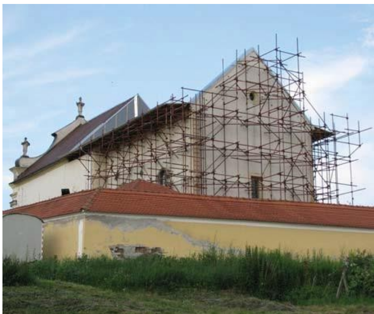
Slika 64. Podupiranje trijumfalnog luka i pridržanje zidova svetišta
