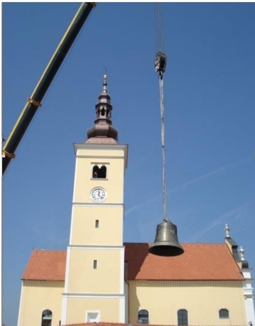
Slika 67. Rekonstruiran zvonik i postavljanje zvona (snimljeno 2011.)
