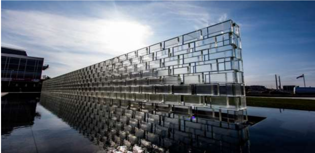
Slika 7. Dio spomenika Domovini - Zid svjetlosti . Izvor: https://fotografijezagreba.hr/zid-svjetlosti-zanimljivi-detalj-jednog-od-tri-dijela-spomenika-domovini/
