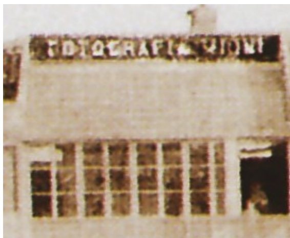
Sl. 52. Ostakljeni zid i natpis fotografskog atelijera Luigija Mionija, Hotel Riboli, Pula
