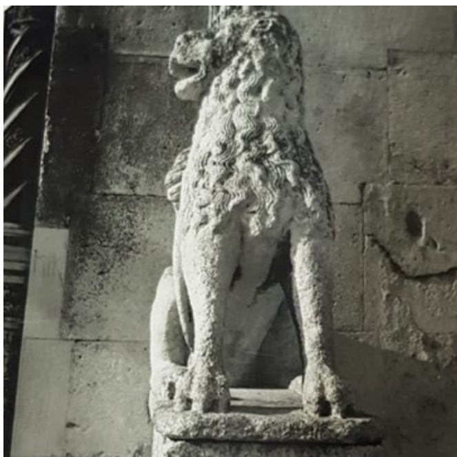
Slika 10. Detalj sjevernog portala, oštećenja kamena uslijed djelovanja (snimljeno 1971. godine), u: Ministarstvo kulture i medija – Središnja dokumentacija kulturne baštine, Zbirka elaborata zaštitnih radova 1756, 1971.
