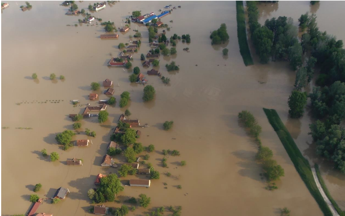
Abbildung 19: Stelle, an der das Wasser durch den Damm entlang der Save durchdrang, in der Nähe der Siedlung Rajevo Selo im Teil der Region Posavina um die Stadt Županja am 17. Mai 2014
