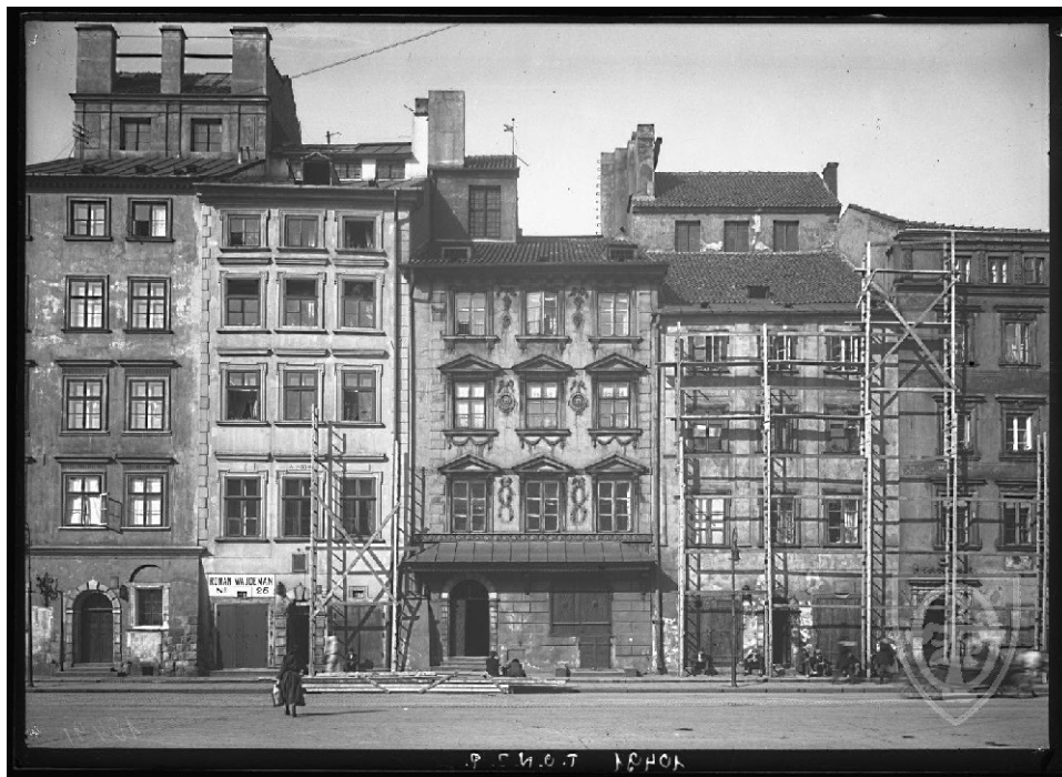
Slika 61: Strana Kollajtaja 1928. sa skelama podignutima za obnovu pročelja
