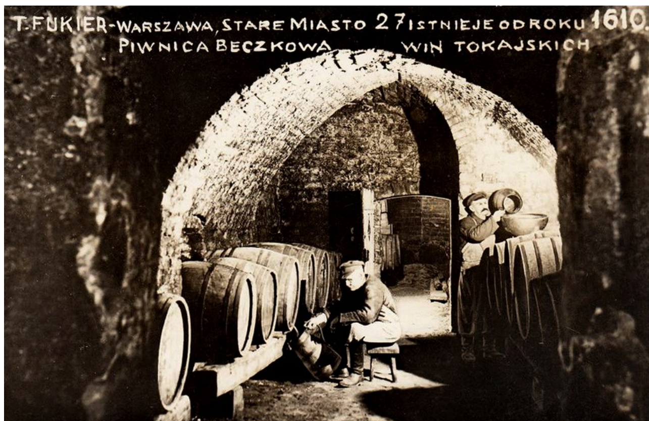
Slika 57: Podrumi kamienice Fukier 1915., vinski podrum Fukiera
