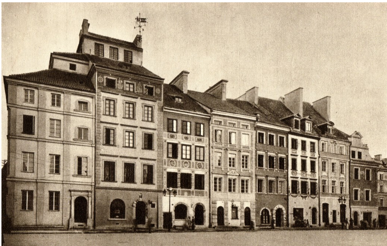
Slika 32: Strana Zakrzewskiego nakon obnove, 1953.
