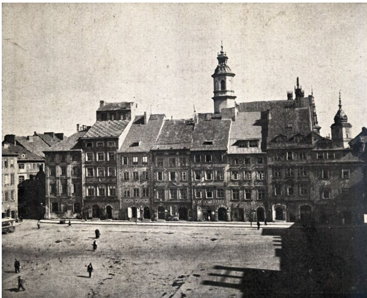
Slika 17: Strana Zakrzewskiego 1935.-1939., treća zgrada s lijeva
