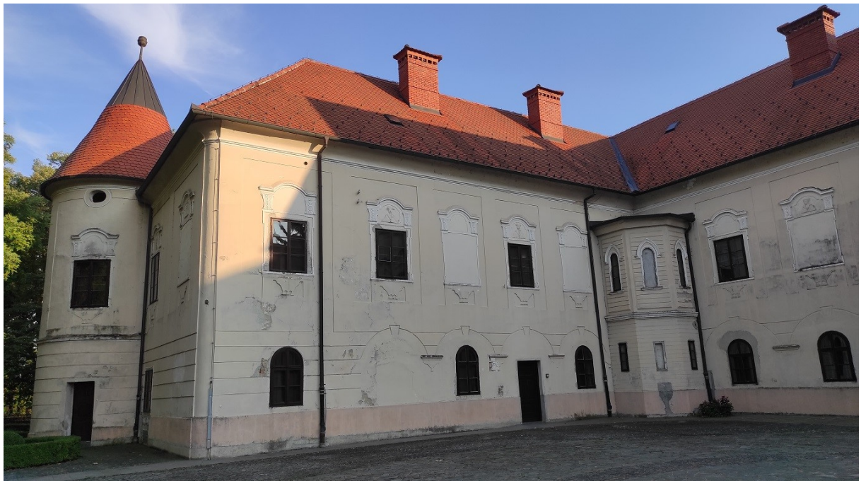
Slika 36 – Zazidani arkadni trijemovi u prizemlju i umetnuti prozorski otvori, zazidani prozorski otvori na prvom katu, vidljiv izostanak razdjelnog vijenca između prizemlja i prvog kata (na cilindričnoj ugaonoj kuli još postoji), neogotička poligonalna kulica, sjeverno dvorišno pročelje, dvorac Lužnica
