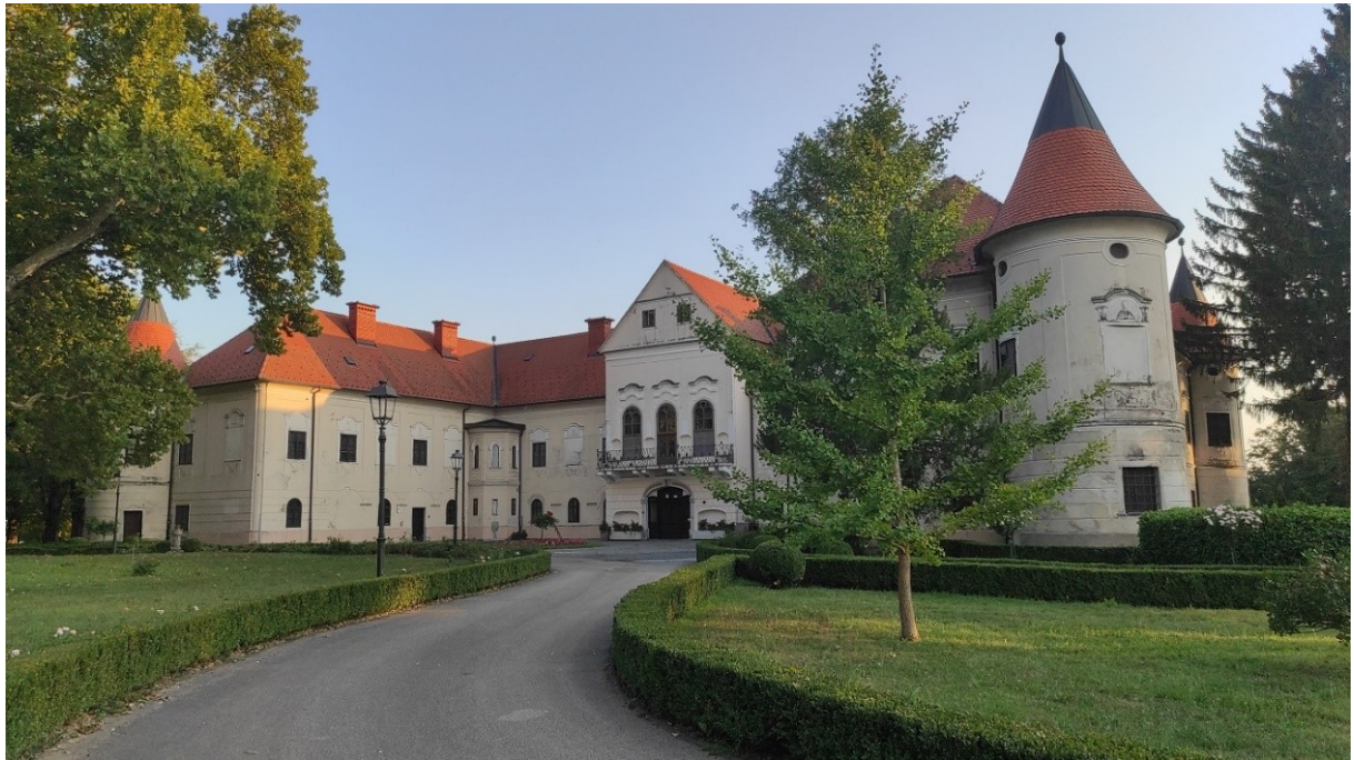
Slika 35 – Sjeverno dvorišno pročelje, dvorac Lužnica
