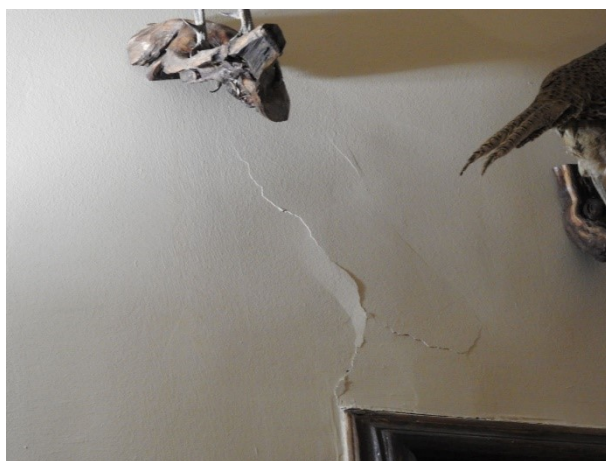
Slika 63 – Pukotine na zidnim površinama u interijeru nastale nakon potresa 28. i 29. prosinca 2020. godine, dvorac Lužnica
