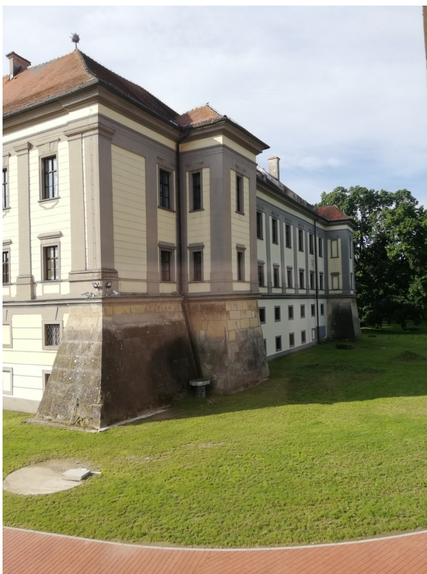
Slika 6: Kontrafor sjeveroistočnog i sjeverozapadnog krila te kutni rizaliti sjeverozapadnog krila, pogled sa sjevera
