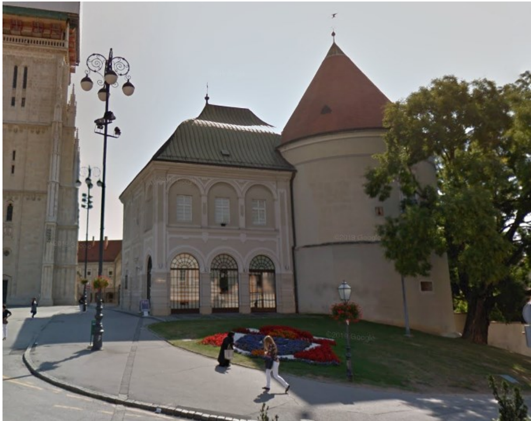
Sl. 7. Današnji izgled Bolléove prigradnje kuli Nebojan
