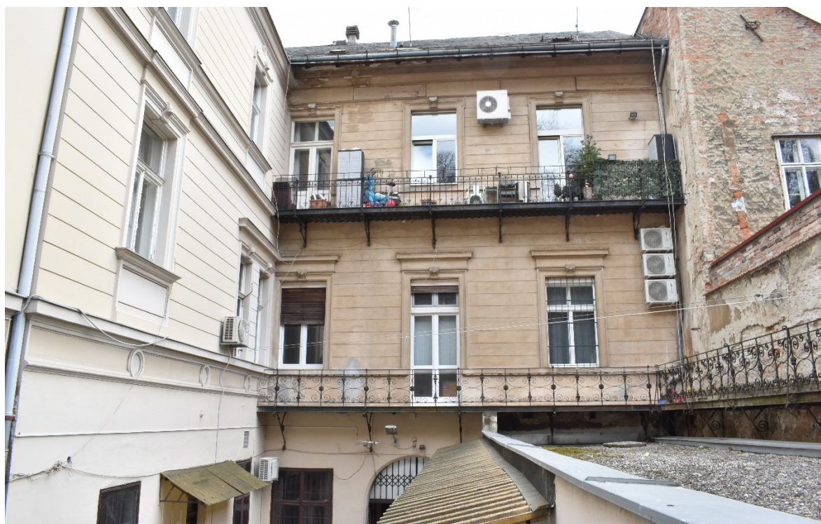
Sl. 50. Prostor u kojem se nalazio atelijer braće Varga, a koji je nakon zatvaranja njihova obrta adaptiran i nadograđen u stambene svrhe, dolje desno na ovoj fotografiji vidljiv je krov prizemnog objekta Foto Centar , fotografirano 30. ožujka 2021. (M. Šafarić)
