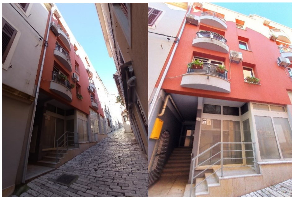
Slika 45. Stambeni dio zgrade u Usponu sv. Franje Asiškog – detalj pročelja
