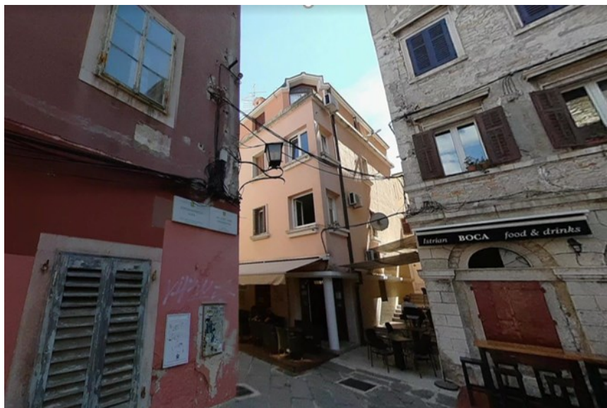
Slika 50. Ugao zgrade iz smjera Katedrale
