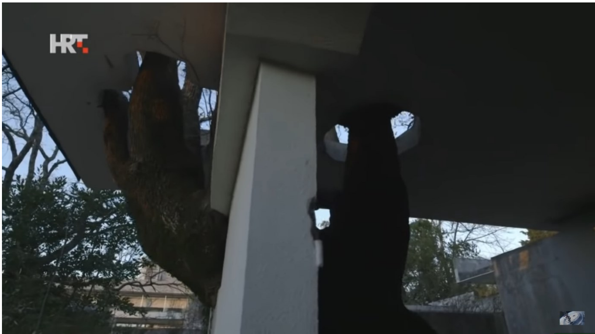
Slika 101. Detalj u naselju vila pored modernističkog hotelskog kompleksa u Haludovu na otoku Krku
