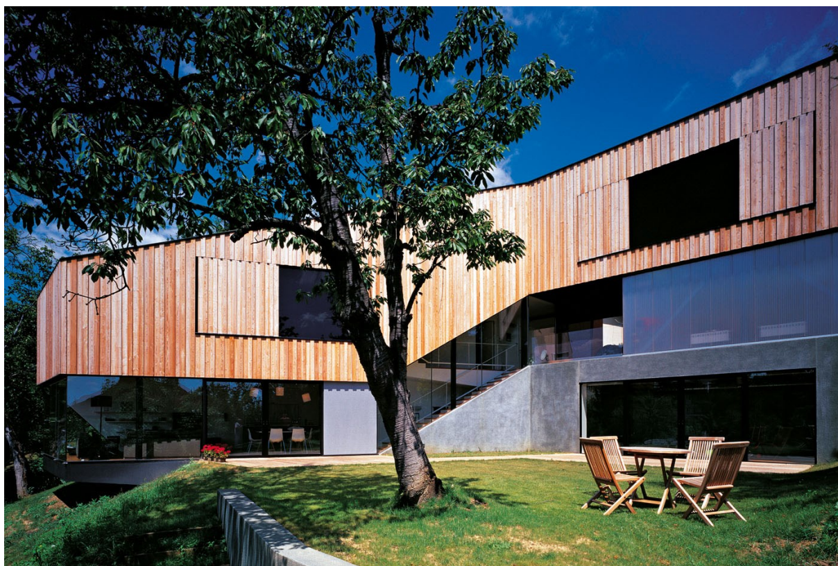
Slika 72. Dvorišno pročelje Kuće J2 pri završetku izgradnje
