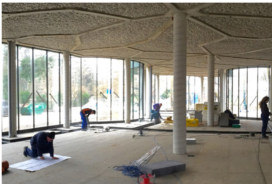
Slika 103. Zapadni dio Zelenog paviljona tijekom izgradnje
