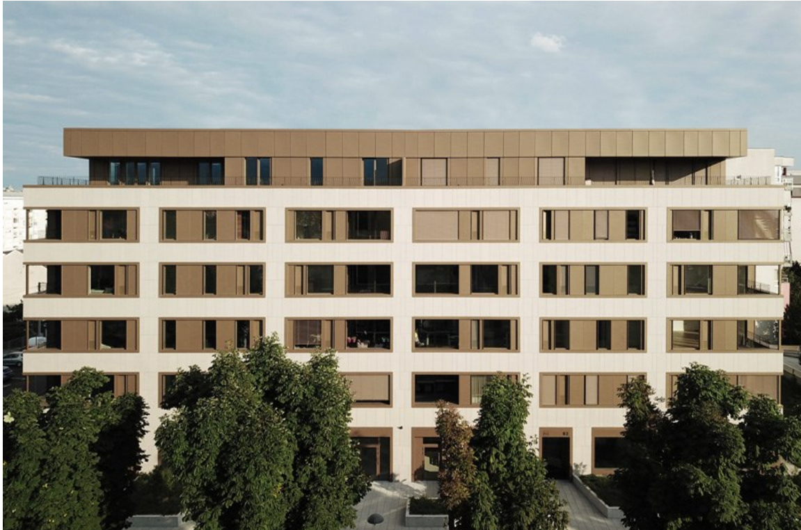
Slika 44. Sjeverno pročelje stambenog Bloka Bužanova
