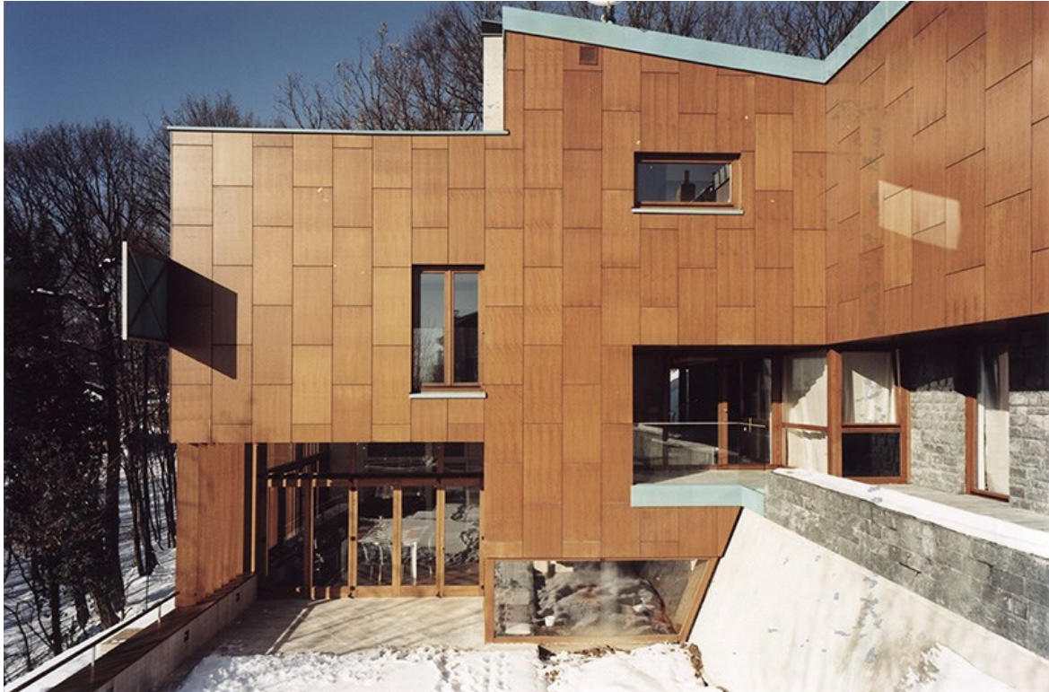
Slika 62. Južno dvorišno pročelje Vile Klare
