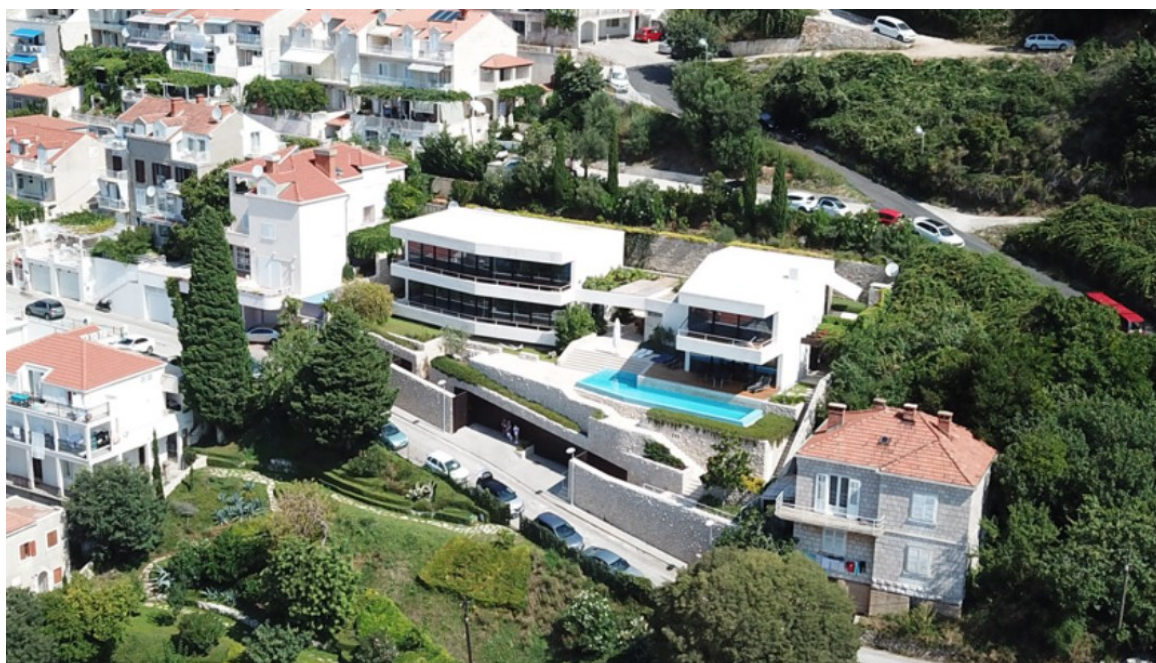
Slika 84. Kuća U u Pločama pored Dubrovnika
