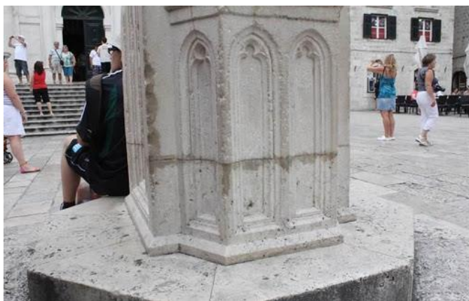
Slika 41. Spoj između starog i novog dijela kamena na postamentu
