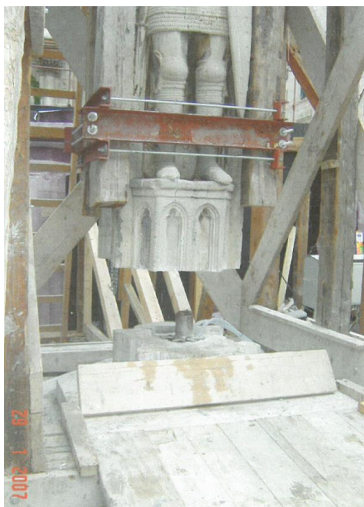
Slika 36. Montaža stupa
