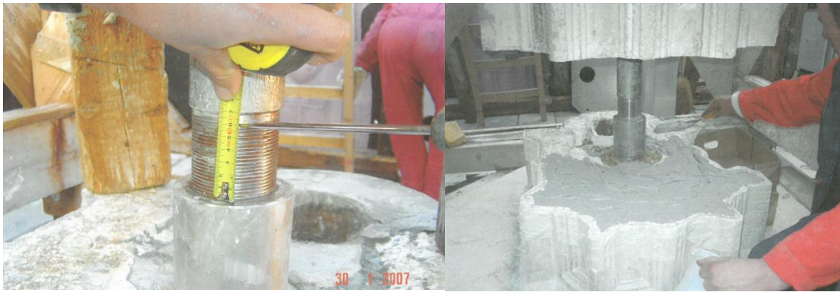
Slika 38. Nenavijeni dio nakon montaže
