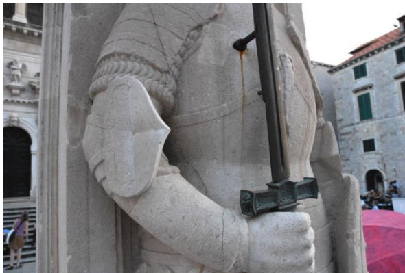
Slika 43. Detalj- pukotina preko oklopa i desnog ramena
