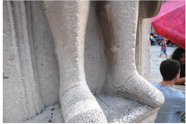
Slika 42. Pukotina preko postamenta i između nogu viteza
