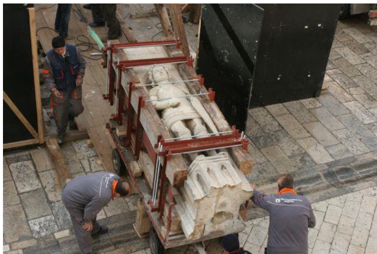
Slika 29. Demontaža stupa
