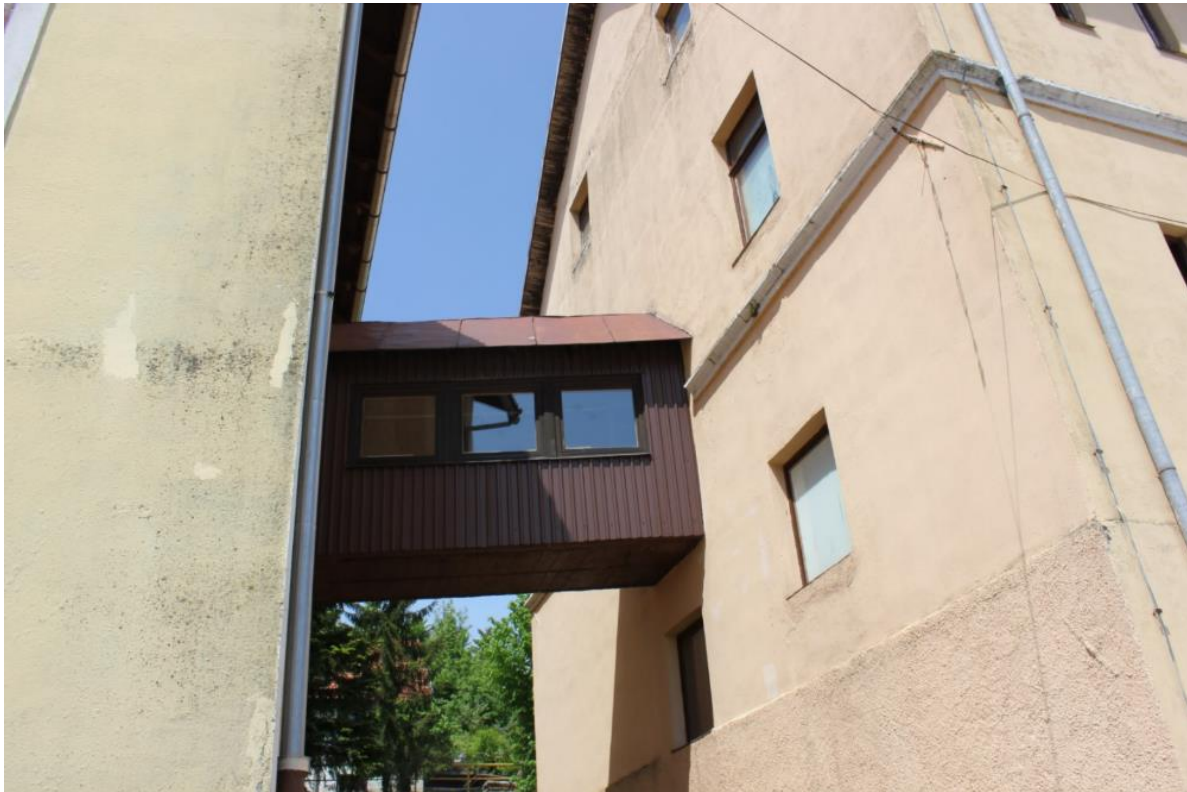
Slika 20. Most između školske i nekadašnje općinske zgrade (fotografirala Morana Jarec, 17. svibnja 2015.)
