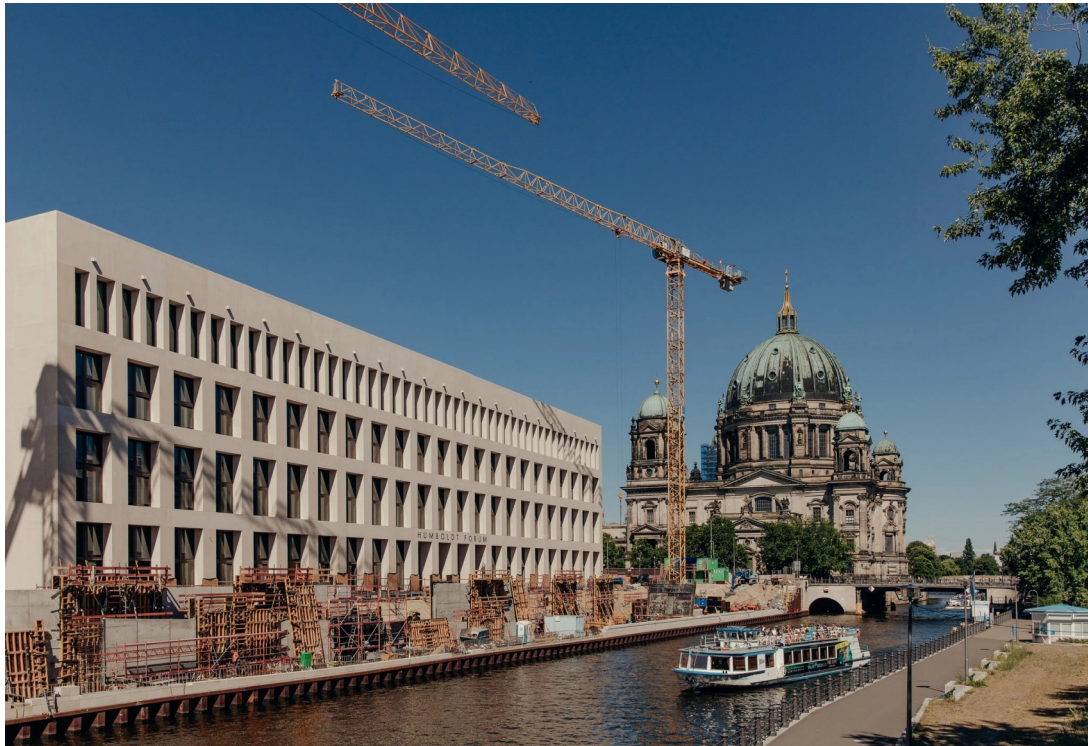
20. Humboldtov forum, pogled na istočno pročelje u suvremenom arhitektonskom rješenju.
