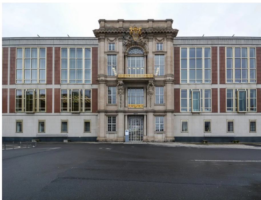
8. Portal IV Gradskog dvorca na nekadašnjoj zgradi Državnog vijeća u Berlinu.
