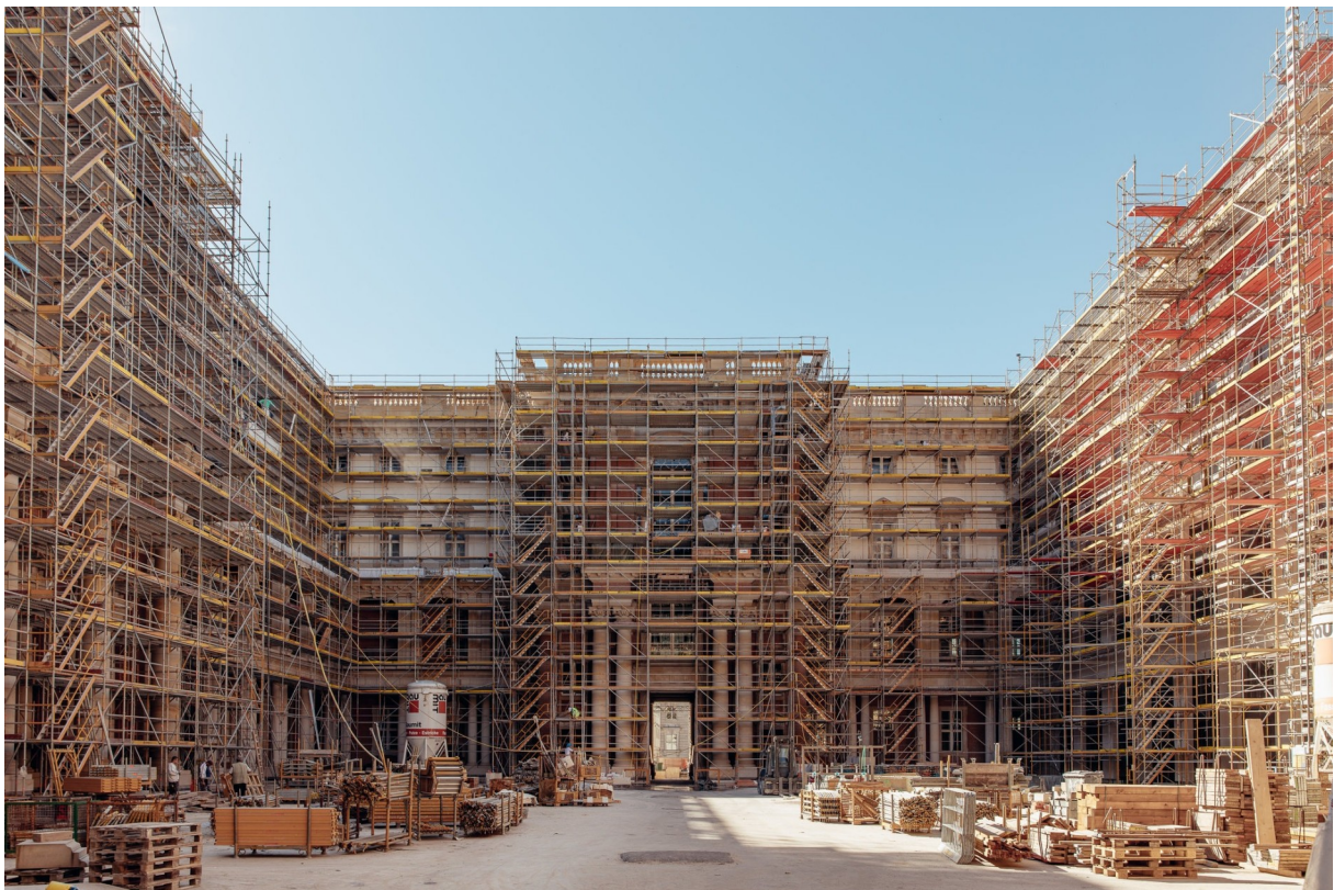
1. Dvorište Humboldtova foruma u vrijeme rekonstrukcije, srpanj 2018.
