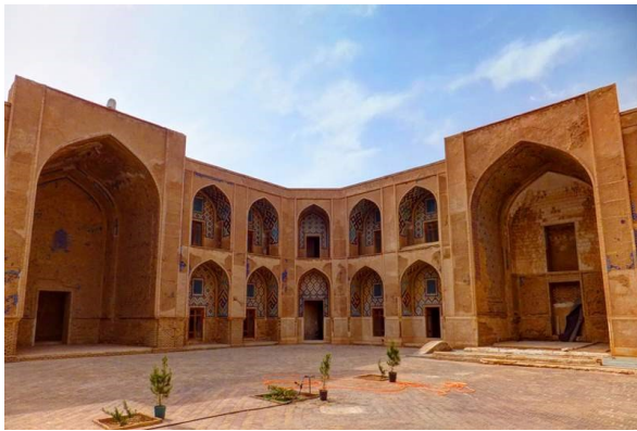
Slika 45: dvorište al-Ġiyāšīyya medrese, pogled na zapadni i sjeverni eywān (izvor: gardeshgari724.com )
