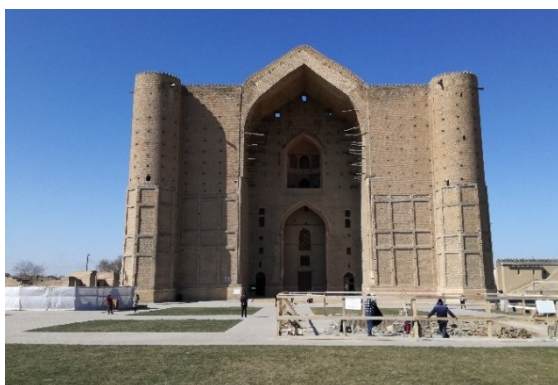
Slika 1: južno pročelje, 2020. (izvor: vlastita fotografija)
