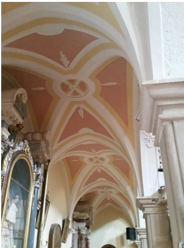
Slika 9. Svodovi bočnih brodova
