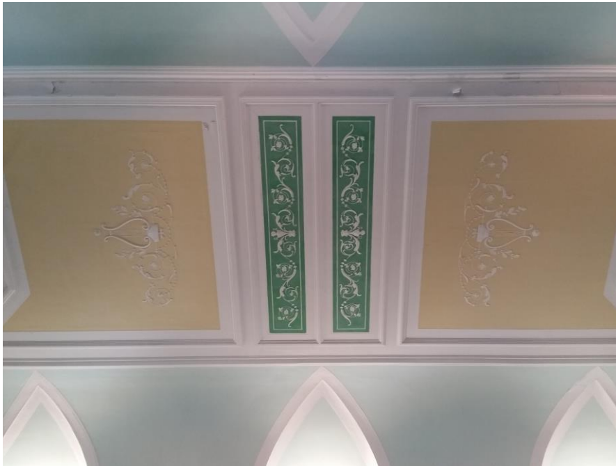
Slika 8. Detalj svoda glavnoga broda
