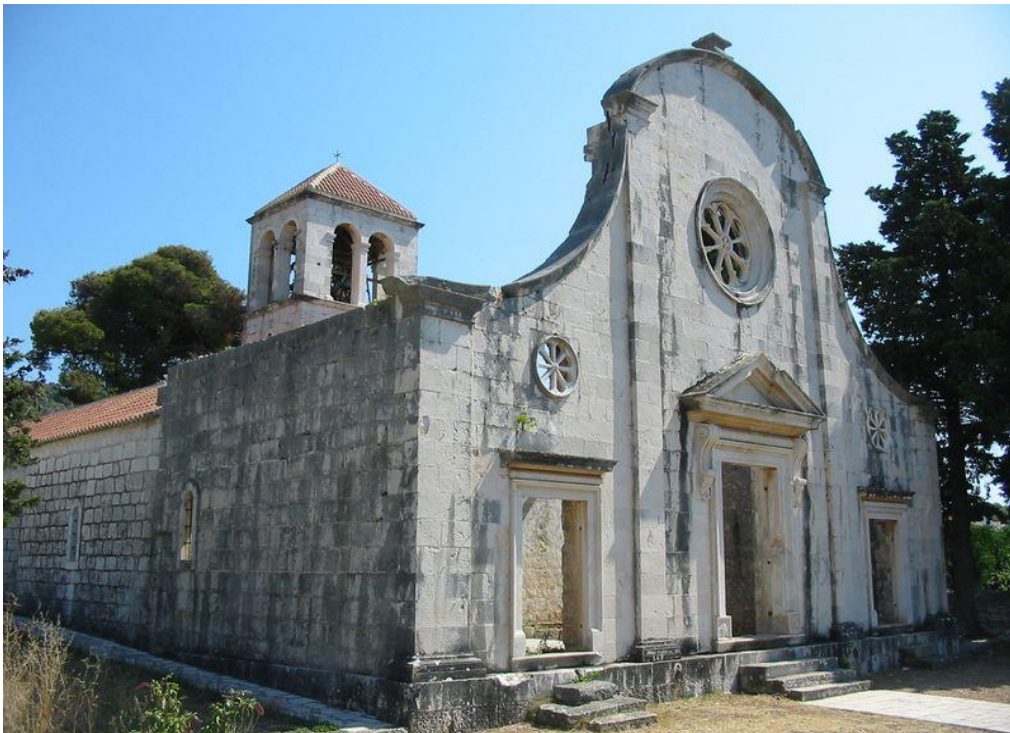
Slika 28. Pročelje župne crkve, Veli Drvenik
