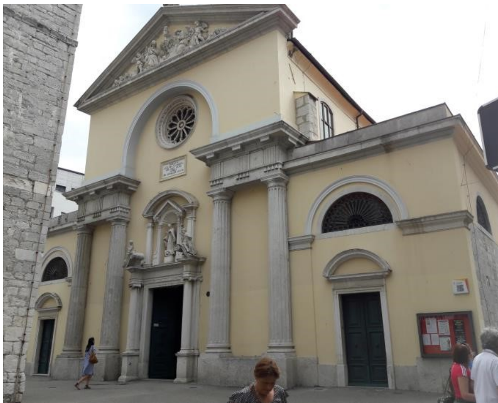
Slika 7. Pročelje crkve Uznesenja Blažene Djevice Marije
