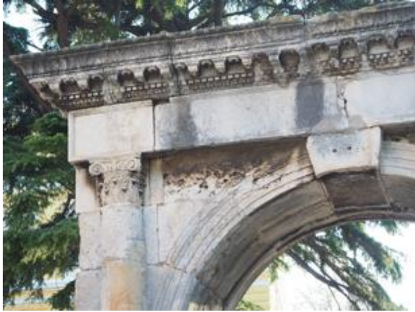
Sl. 3 – Dvojna vrata, detalj s kompozitnim kapitelom i vidljivim utorom za rešetke
