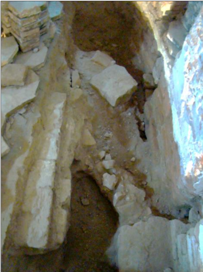
Slika 18: prikaz dijela polukružnog zida ispod temelja crkve (prema: (Klečina i Ivanušec 2009, 21, fot. sonda P.S. 6a)
