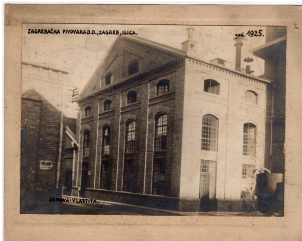
Slika 28. Tvrnička zgrada Zagrebačke pivovare, građevinsko poduzeće Pollak i Bornstein, 1925.
