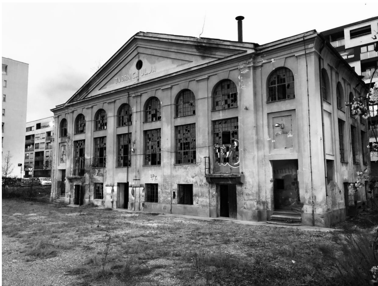
Slika 50. Zgrada kotlovnice i strojarnice, stanje iz siječnja 2020. (foto: Iva Neljak)
