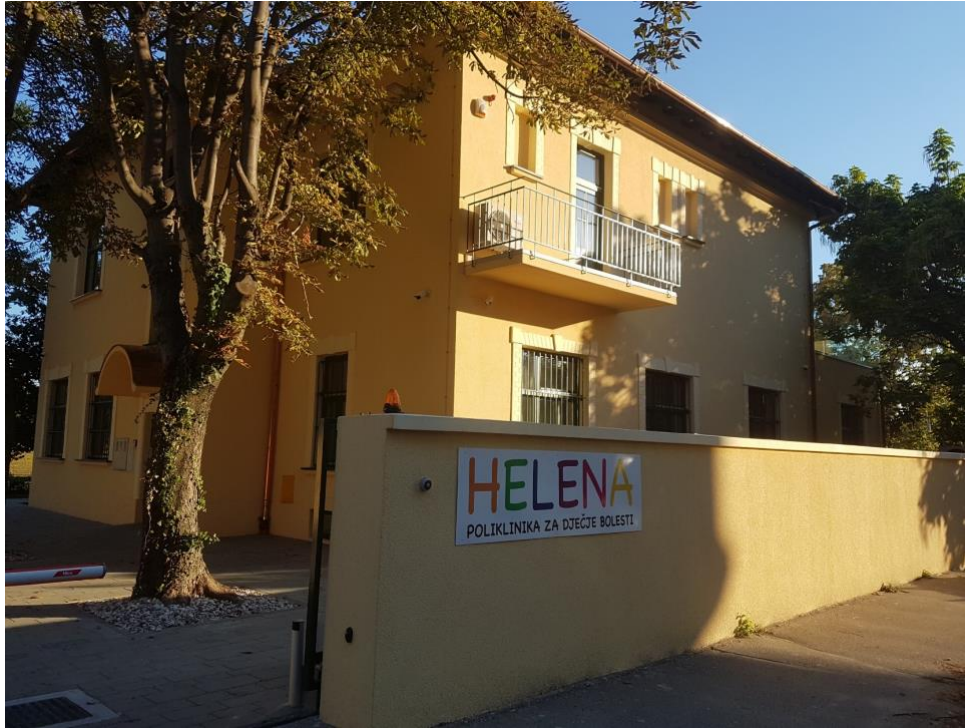
Slika 17. Zgrada poliklinike Helena (sjeveroistočna strana)
