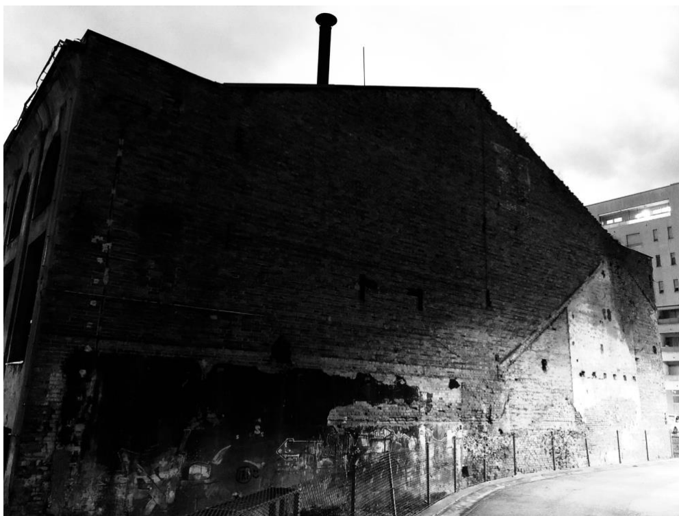
Slika 39. Stražnja/sjeverna strana zgrade kotlovnice i strojarnice sa vidljivim tragom dvostrešnog krova i zidova susjedne kuće na zapadnoj strani, stanje iz siječnja 2020. (foto: Iva Neljak)
