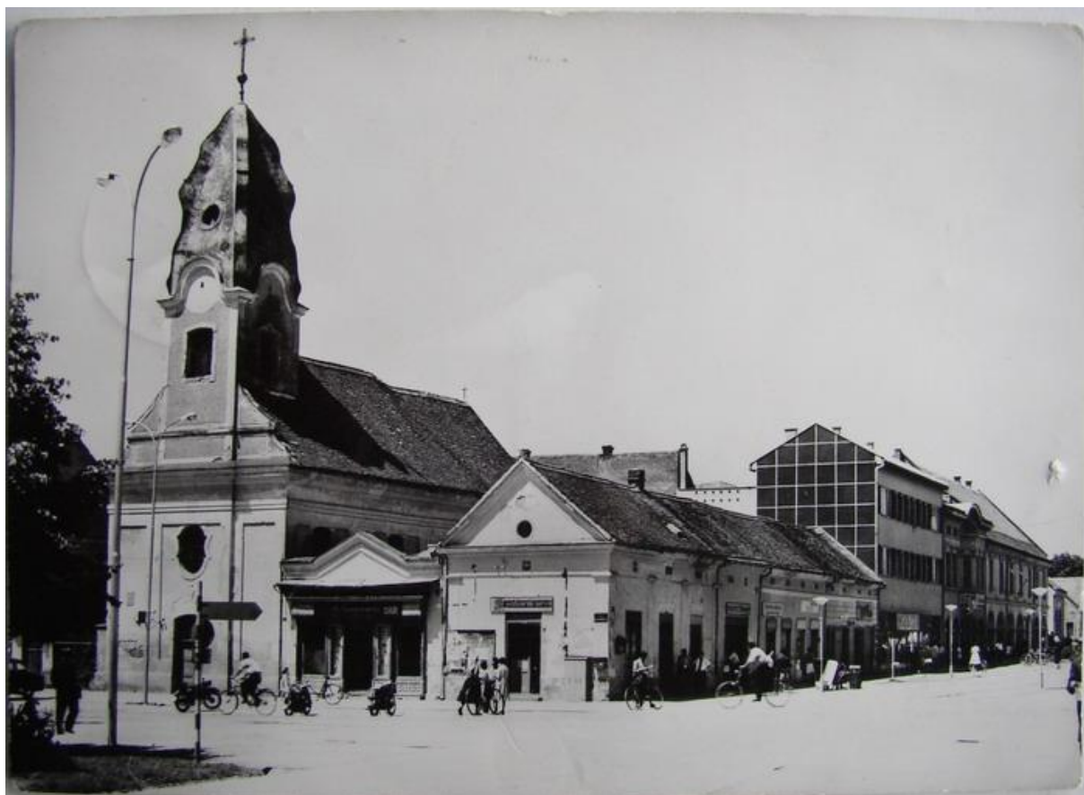
Slika br. 3 Crkva sv. Terezije , stanje prije izgradnje robne kuće na uglu (izvor: https://radiong.hr/danas-slavimo-dan-grada-blagdan-zupe-bezgrjesnog-zaceca-blazene-djevice-marije/ )
