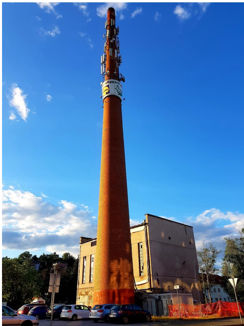
Slika 16. ZIVT – kotlovnica i dimnjak (vlastita fotografija)
