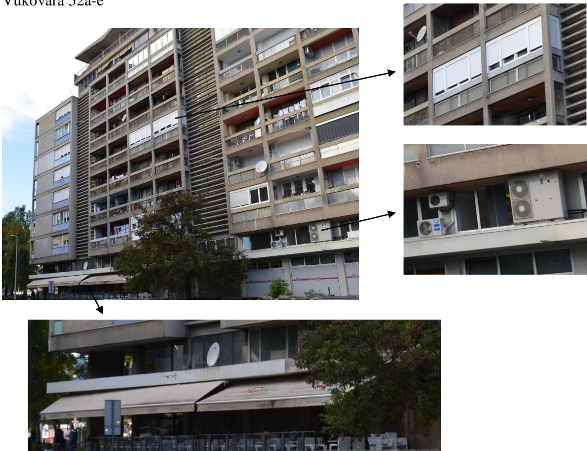
Slika 57. Detalj začelja višestambene osmerokatnice Vojne Mornarice Stanka Fabrisa, Ulica grada Vukovara 52a-e 303
