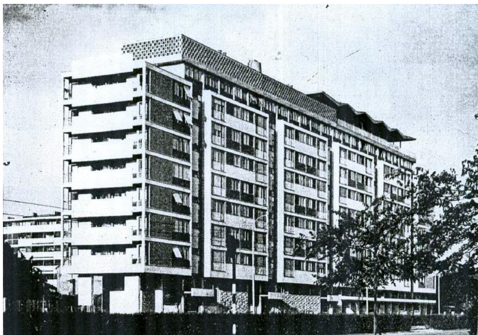
Slika 52. Pročelje višestambene osmerokatnice Vojne Mornarice Stanka Fabrisa, Ulica grada Vukovara 52a-e 298
