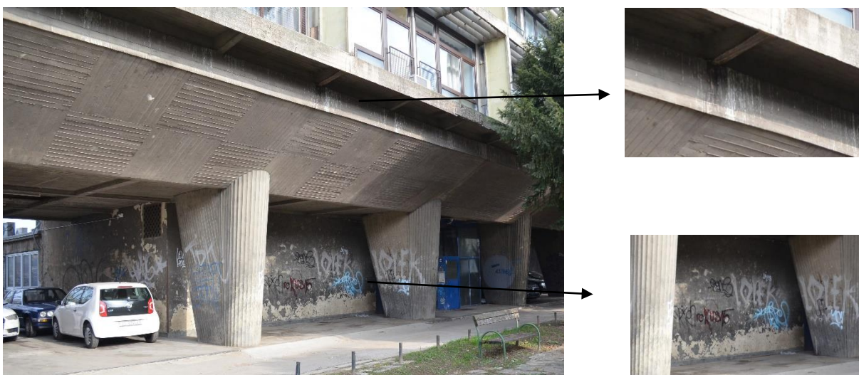
Slika 19. Detalj pročelja stambena zgrade Drage Galića, Ulica grada Vukovara 43-43a 244
