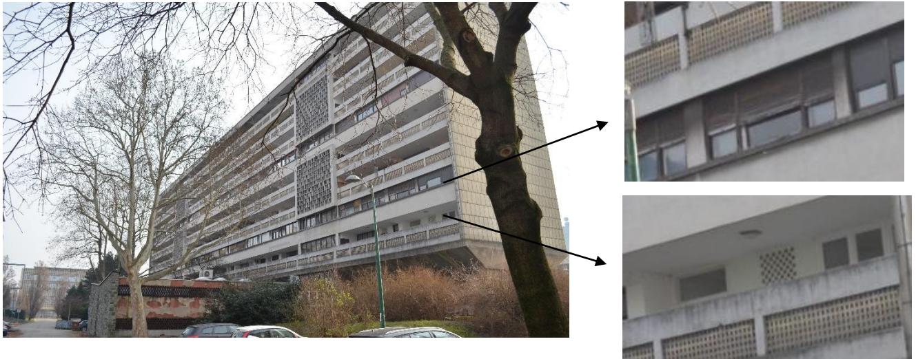
Slika 20. Začelje stambene zgrade Drage Galića, Ulica grada Vukovara 43-43a 245
