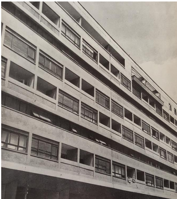
Slika 5. Detalj pročelja stambene zgrade Drage Galića u Ulici grada Vukovara 35-35a 223
