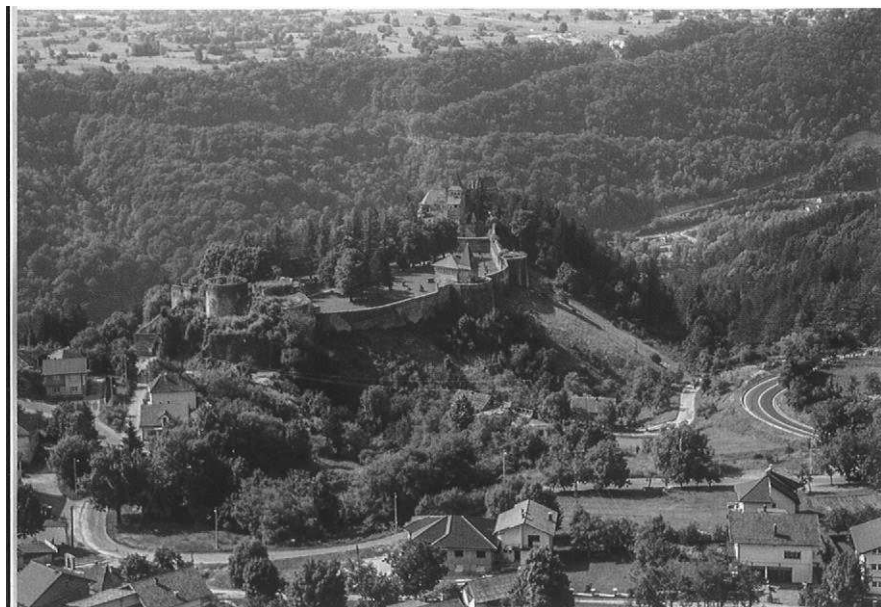
Reste der spätmittelalterlichen Festung Ostrožac an der Una
