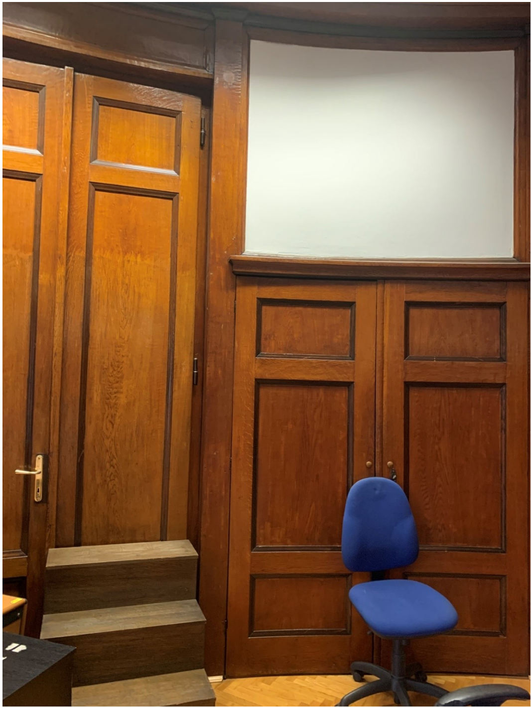
Slika 24. Ugrađeni ormar i drvene obloge zida u svečanoj dvorani polukata, današnje stanje
