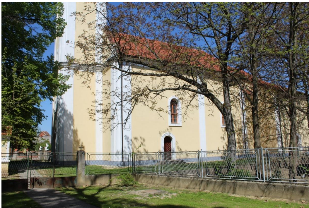
Slika 14. Istočno pročelje crkve
