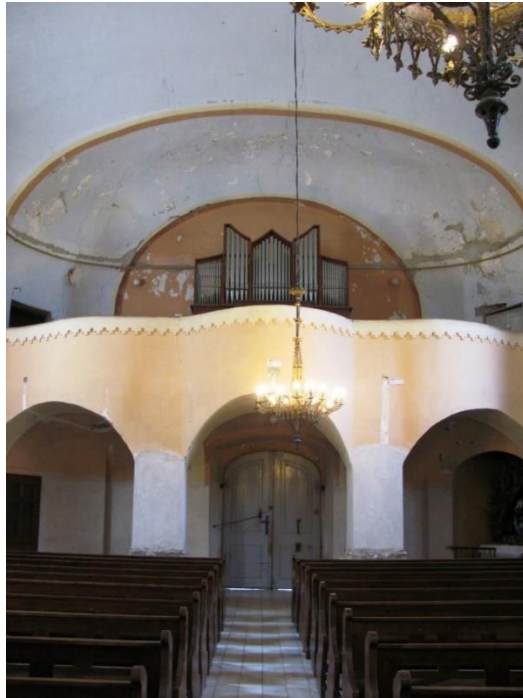
Slika 15. Pogled na ulazni prostor crkve i kor
