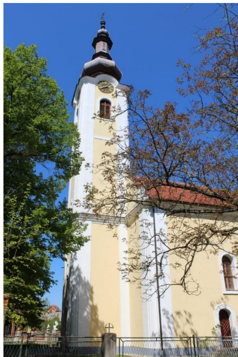
Slika 11. Pogled na zvonik crkve i istočno pročelje
