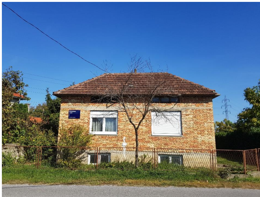
Prilog 32. Kuća na adresi Matunova 1, sagrađena sredinom 20. stoljeća, obnovljena PVC prozorima, autor: Martina Petrović, kolovoz 2019.
