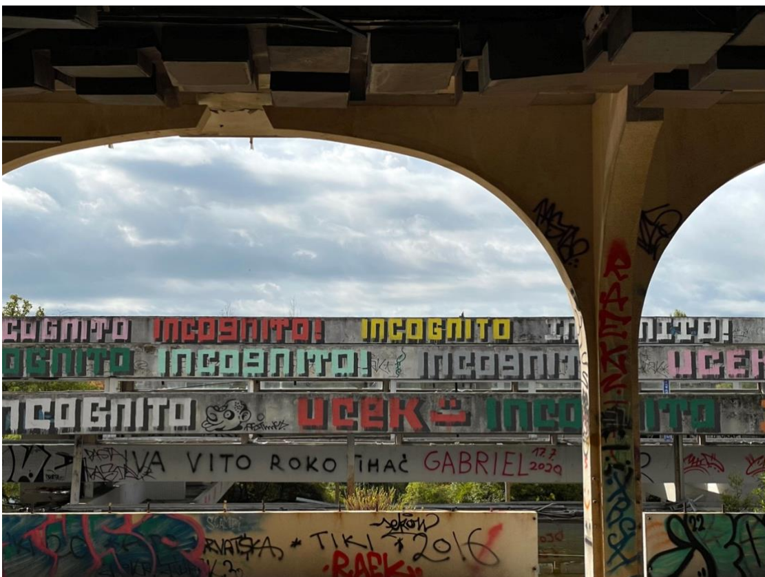
Sl. 10. Pogled s galerije na lebdeće armiranobetonske elemente iznad bazena
