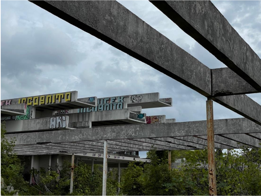
Sl. 25. Armiranobetonska pergola na velikoj terasi i pogled na „skakaonice“
