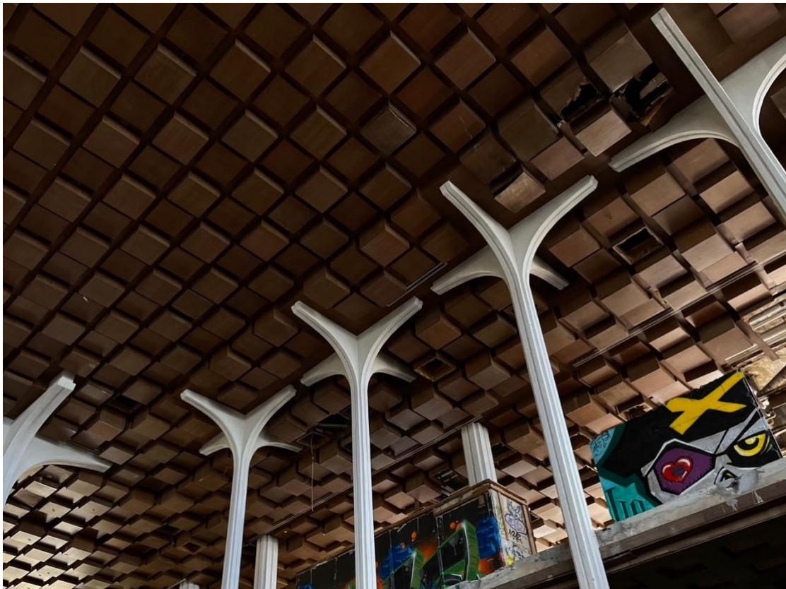
Sl. 13. Detalj stupova u središnjem prostoru
