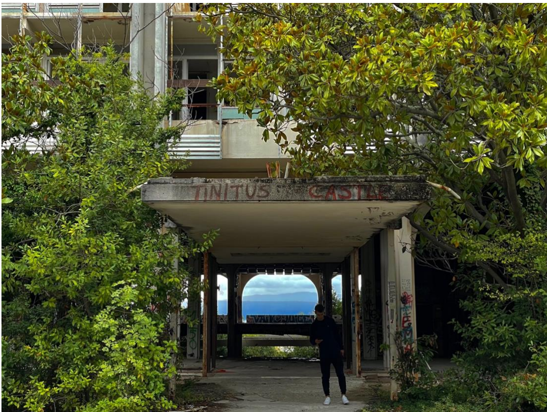
Sl. 6. Glavni ulaz u Hotel Palace – početak glavne osi
