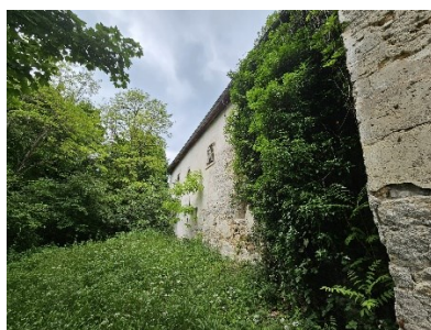
35. Pogled na južno pročelje prizemne građevine na jugu.
