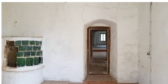
32. Pogled prema sjeveru prostorije na prvom katu jugoistočne kule s erkerima i kaljevu peć (kroz otvor vrata nazire se prostorija prvog kata ulaznog krila).
