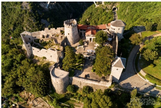
47. Pogled na kaštel Trsat iz zraka.
