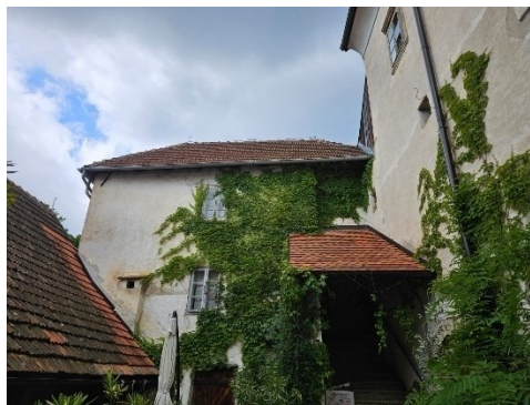
11. Pogled na stubište u sjeverozapadnom kutu.
