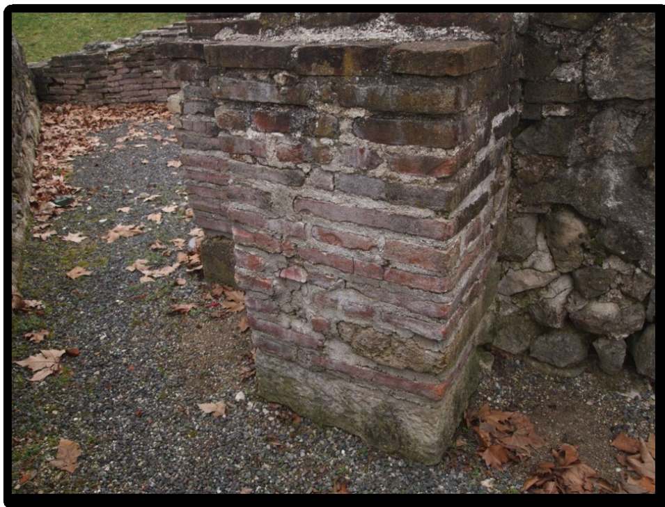
18– Kontrafor s vanjske strane II zida žitnice; stanje u ožujku 2024. (snimio: F. Jajčinović)
