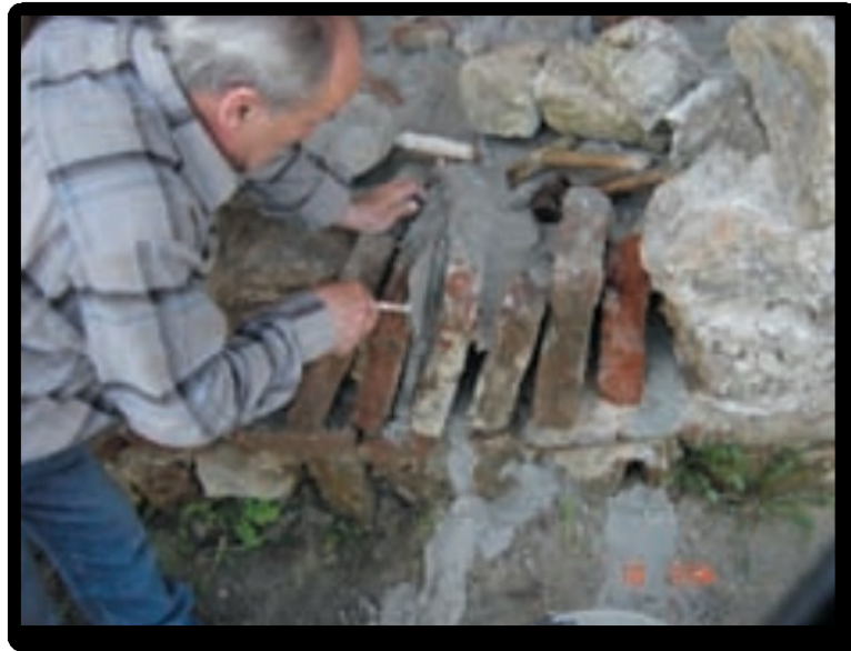
41 – zapunjavanje reški zamjenskim vezivnim materijalom(preuzeto iz: Lolić 2006., str. 205.)
