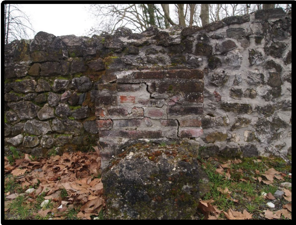
17 - Kontrafor s unutrašnje strane II zida žitnice; stanje u ožujku 2024. (snimio: F. Jajčinović)
