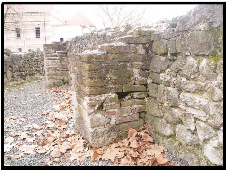
19– Kontrafor s vanjske strane II zida žitnice; stanje u ožujku 2024. (snimio: F. Jajčinović)
