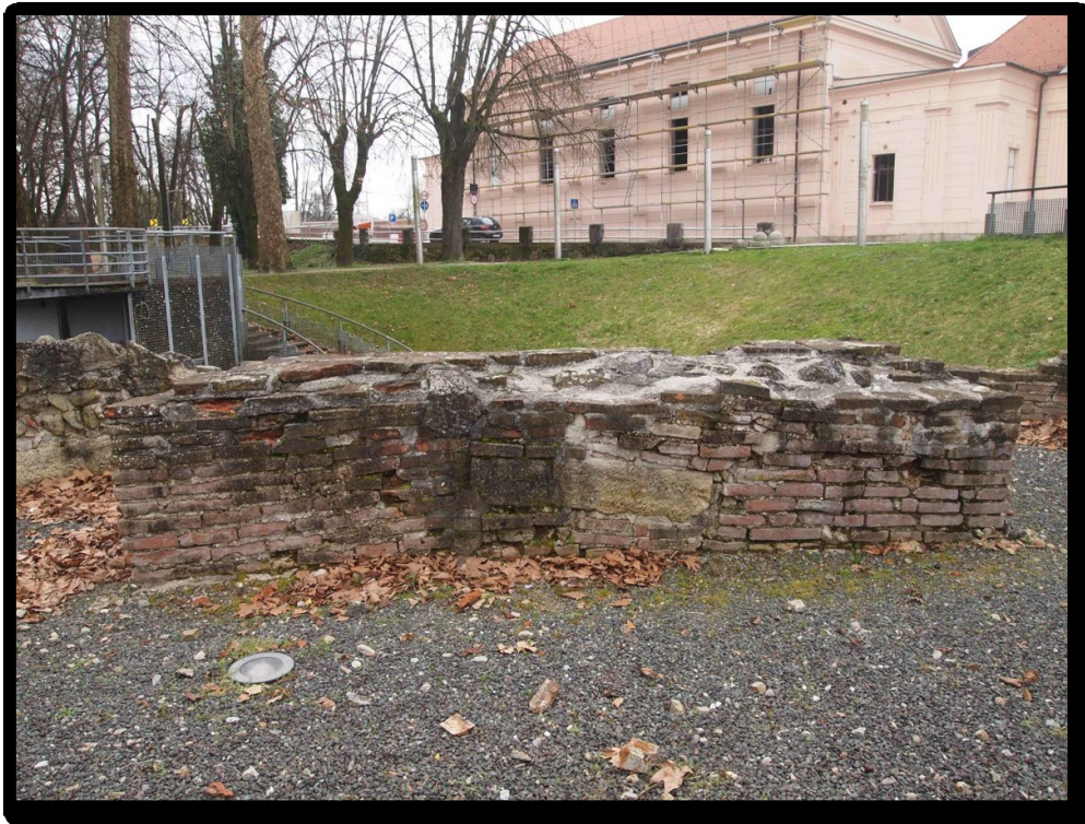
26 – profil SI zida ugaone kule; stanje u ožujku 2024. (snimio: F. Jajčinović)
