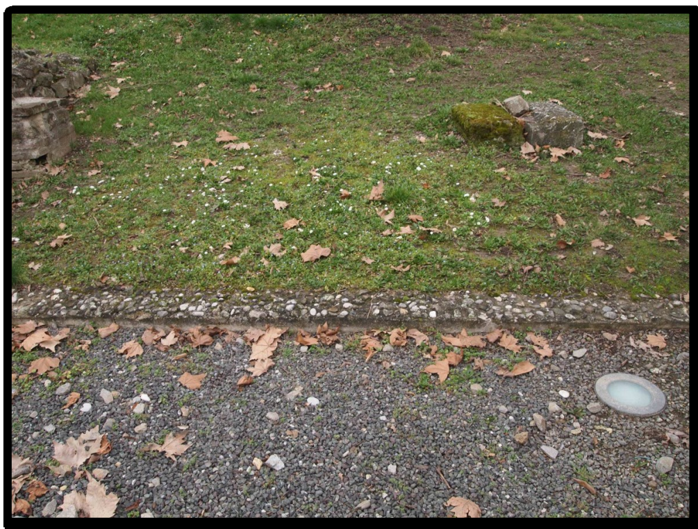
28 – betonska traka koja razdvaja travnatu površinu od sitnog kamena u prezentacijskoj zoni; stanje u ožujku 2024. (snimio: F. Jajčinović)
