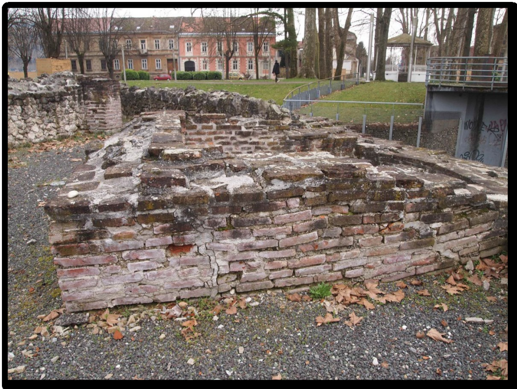
13 – profil sjeverozapadnog zida ugaone kule; ožujak 2024. (snimio: F. Jajčinović)
