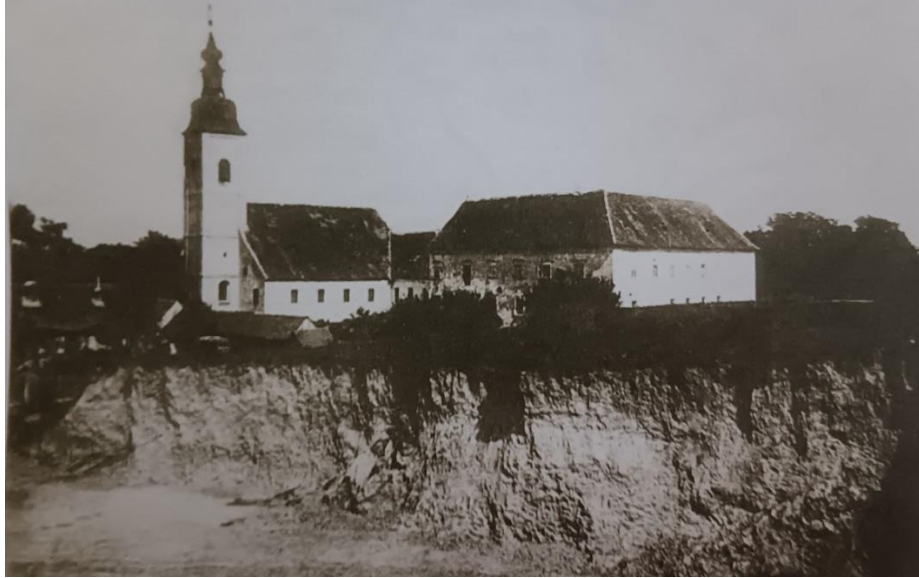
Slika 6. Pogled na franjevački samostan i crkvu prije rušenja samostanskog dijela u XX. stoljeću
