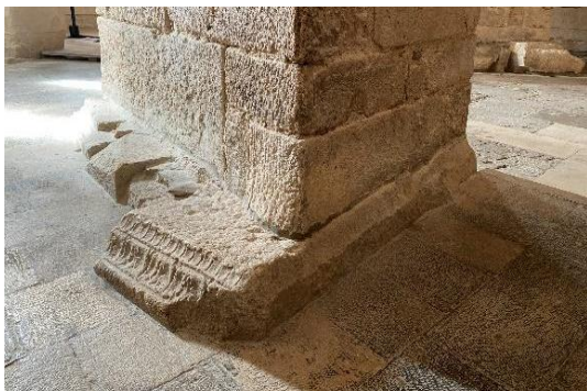
Slika 43. Dio postolja skulpture u temelju trećeg pilona rotonde Sv. Donata. Foto: Hana Buntak
