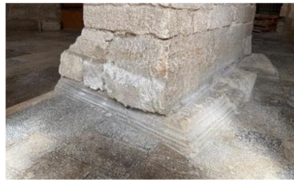
Slika 44. Baza antičkog žrtvenika u temelju trećeg pilona rotonde Sv. Donata. Foto: Hana Buntak
