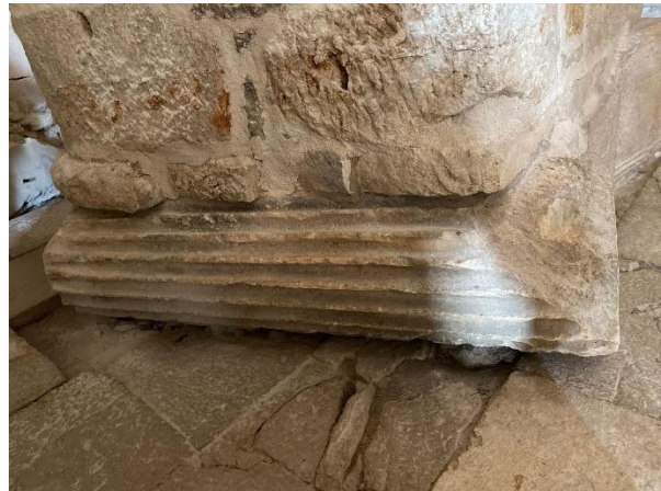
Slika 48. Kanelirani stup u temelju petog pilona rotunde Sv. Donata. Foto: Hana Buntak
