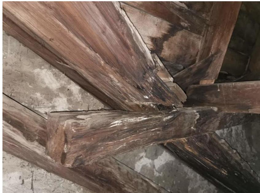
Slika 39.: Prikaz oštećene drvne konstrukcije u dijelu zapadne male kupole
