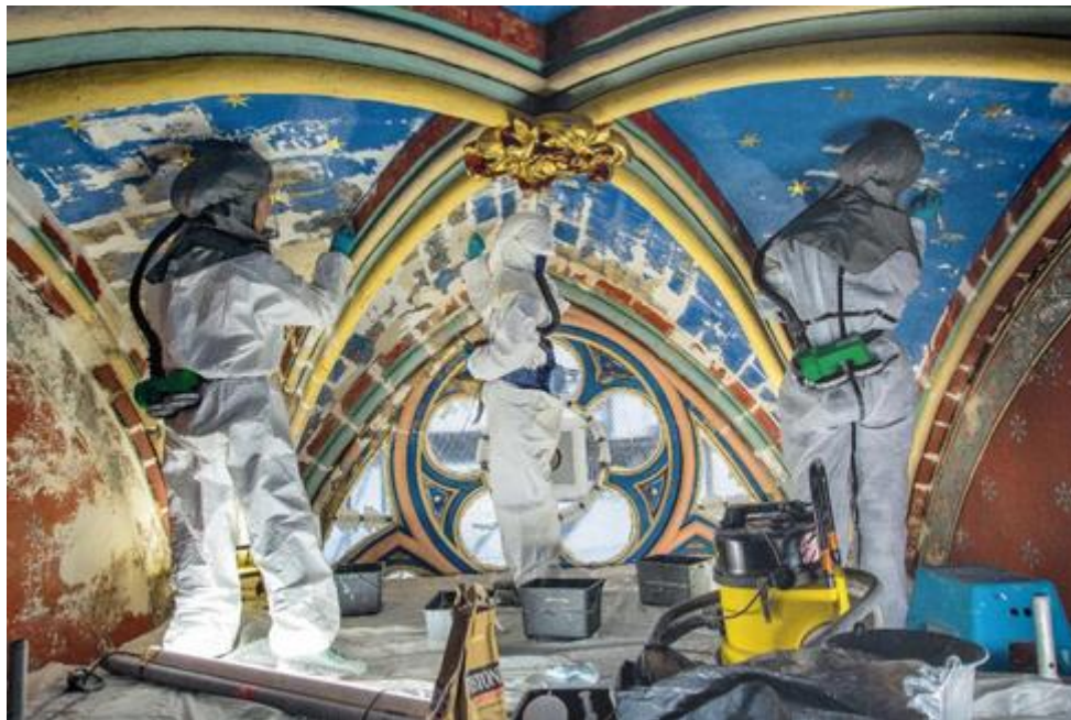
Slika 61. Radovi na kapeli
