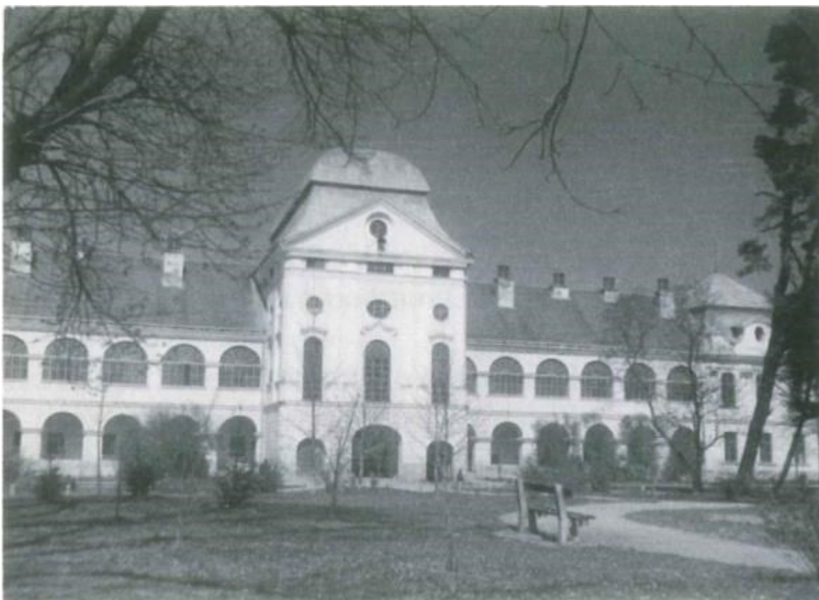
Slika 10: Južno pročelje dvorca nakon obnove 1950-ih godina
