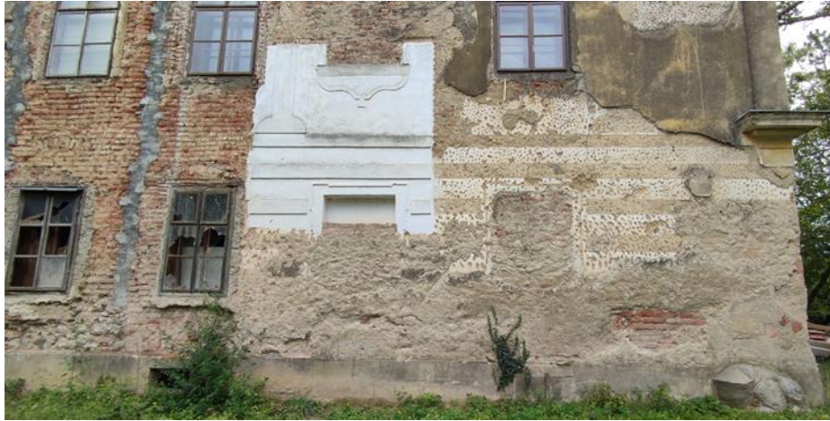
Slika 18: Otvorena restauratorska sonda na sjevernom pročelju
