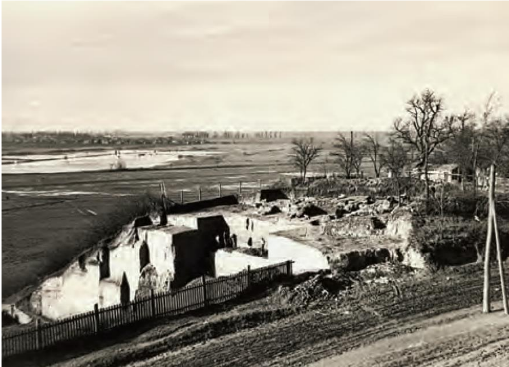
Slika 42 Otkop ciglane s otkrivenim temeljima crkve sv. Mihovila, pogled sa sjeveroistoka.
