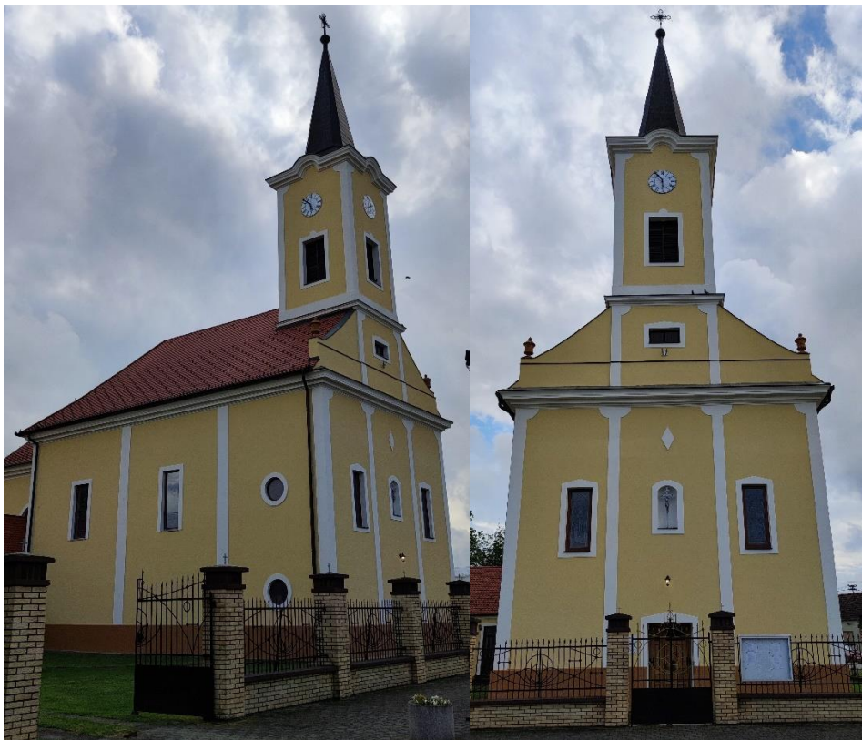
Slika 96 i 97: Pročelje crkve Uzvišenja Svetog Križa u Oprisavcima.
