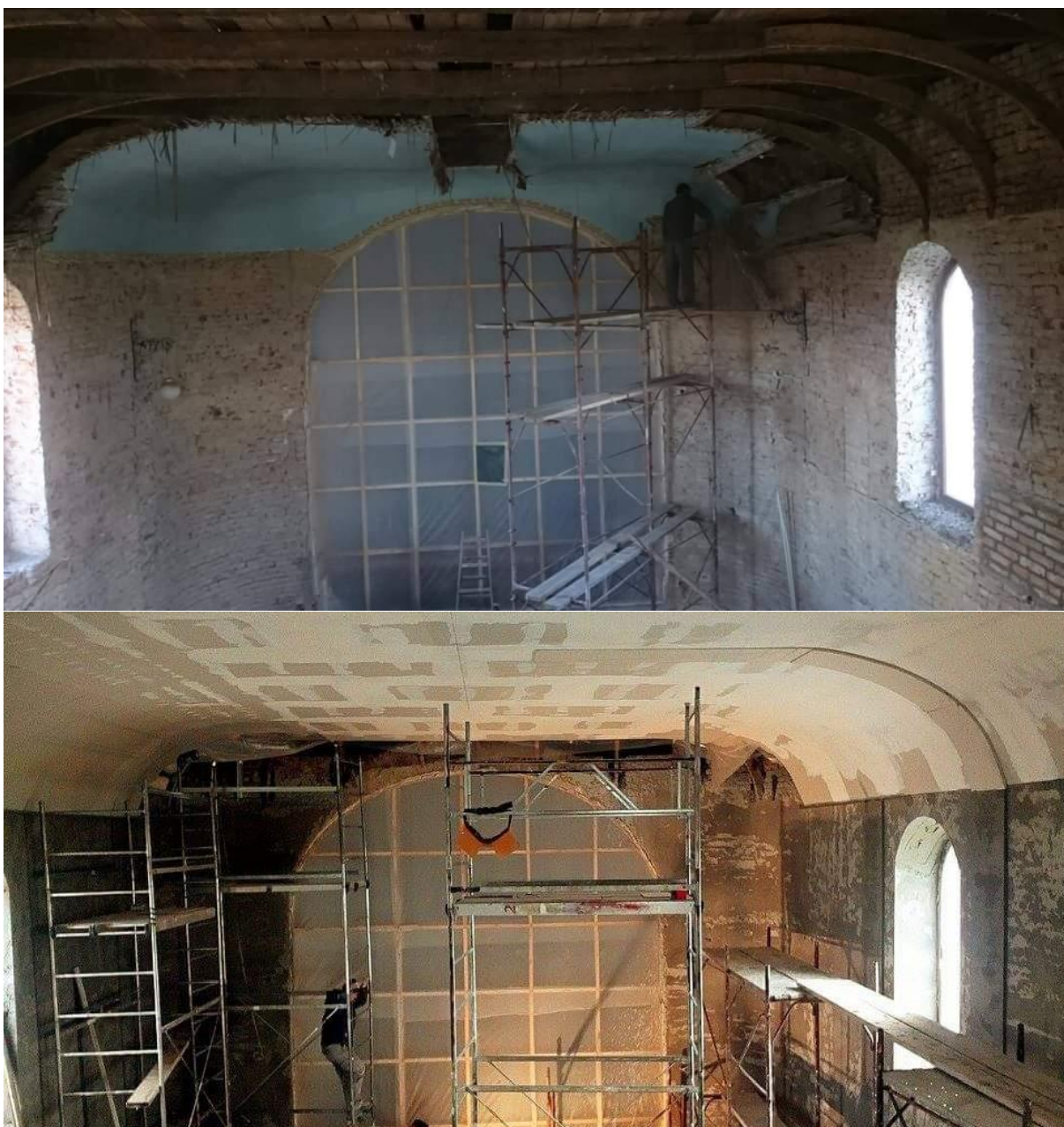
Slika 115 i 116: Uklanjanje svoda i postavljanje novog.
