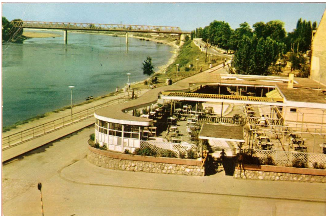
Slika 27. Godine 1953. na lokaciji bivše kuće D'Elia sagrađena je Najlon bašća , prema projektu Vjenceslava Richtera
