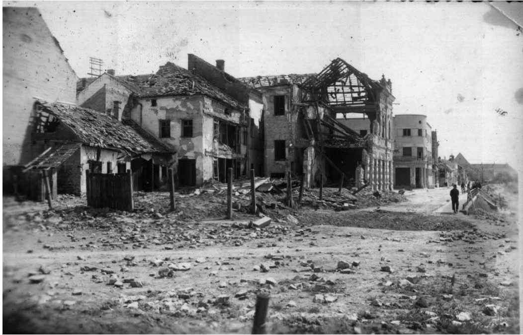
Slika 25. Kuća D' Elia, 1944.
