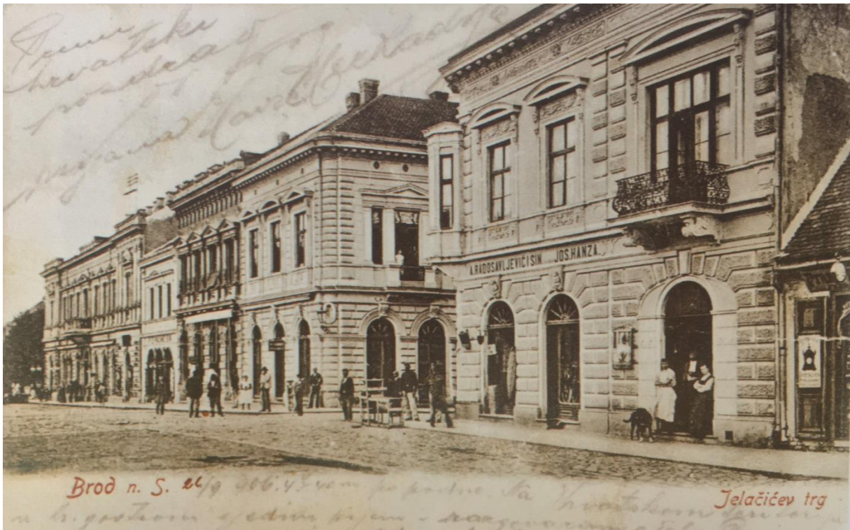
Slika 62. Kuća Radosavljević - Šimić
