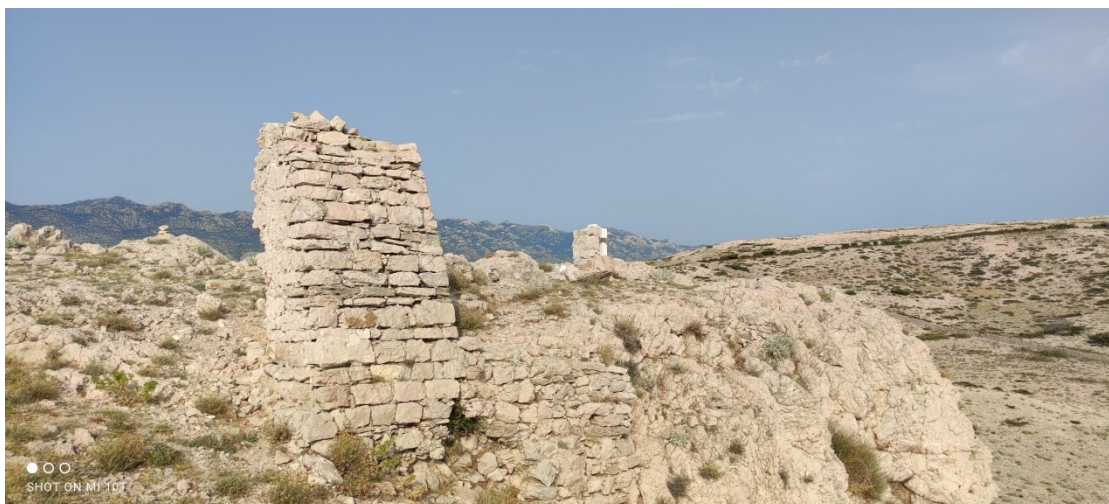
SLIKA 4. Crkva sv. Jurja poviše Paga, ostatak kontrafora. Foto: M. Komar
