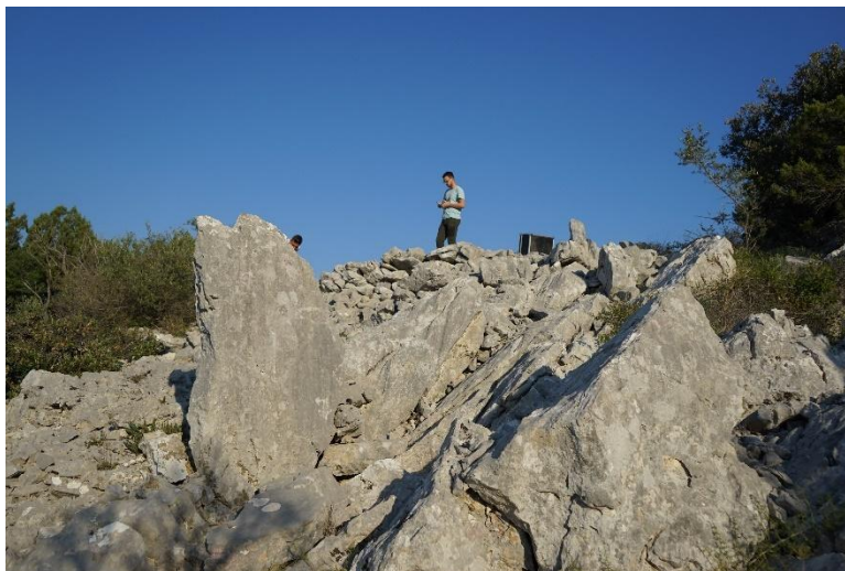
Slika 20 - Dio južnog predbedema na gradini Vela Moševčica, foto: J. Barbarić
