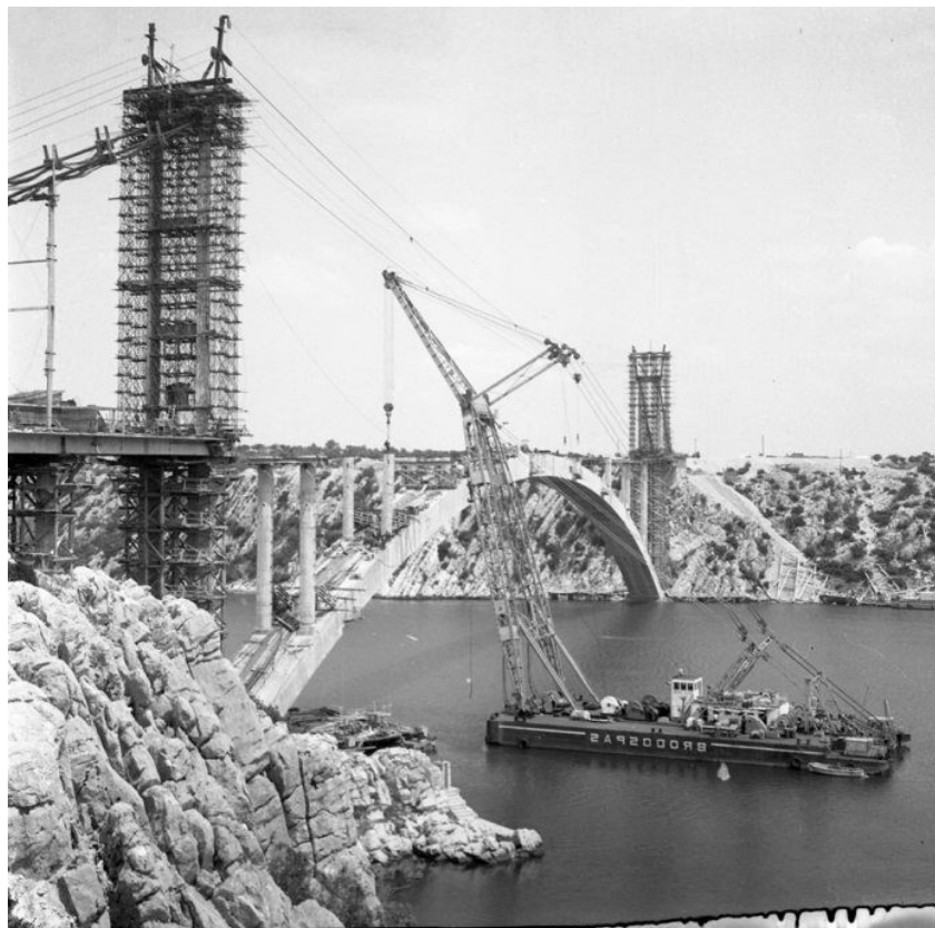
slika br. 4 Šibenski most u izgradnji, u prvom planu nalazi se plovna dizalica Veli Jože
